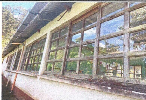
Foto1: Sustrucción de ventana de madera por metal + vidrio. MÓDULO 1
