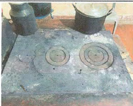
Foto 1: Sustitución de pancha de 3 ornillas, Módulos 3
