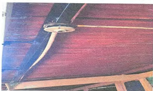
FOTO 3 Modulo1: Instalacion de Unidad de Luz
