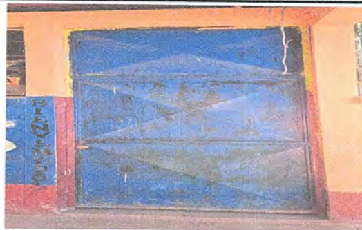
FOTO 4 modulo 1: reparacion de puerta
