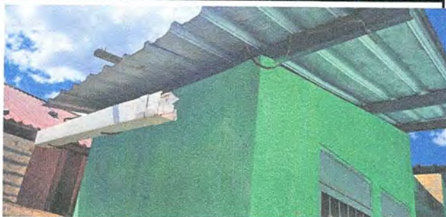
FOTO 5 modulo2: sustitucion de canal
