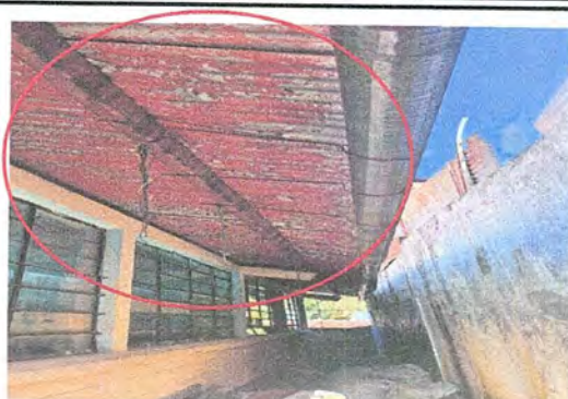
FOTO 2 Modulo1: SUSTITUCION DE ESTRUCTURA DE METAL
