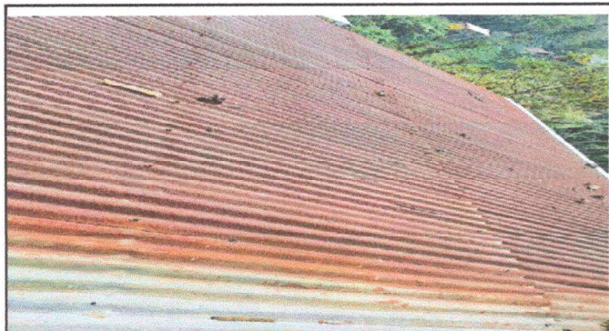
FOTO 1 MODULO 2 SUSTITUCION DE LAMINA DE METAL
