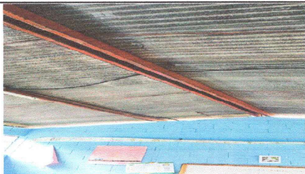
FOTO 2 MODULO 1 MANTENIMIENTO A ESTRUCTURA DE SOPORTE DE METAL
