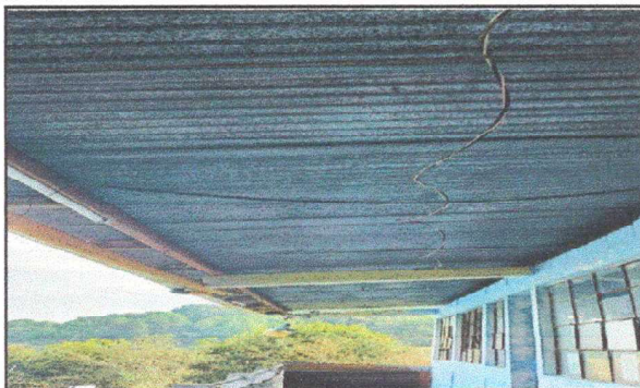
FOTO 1 MODULO 1 SUSTITUCION DE LAMINA DE METAL
