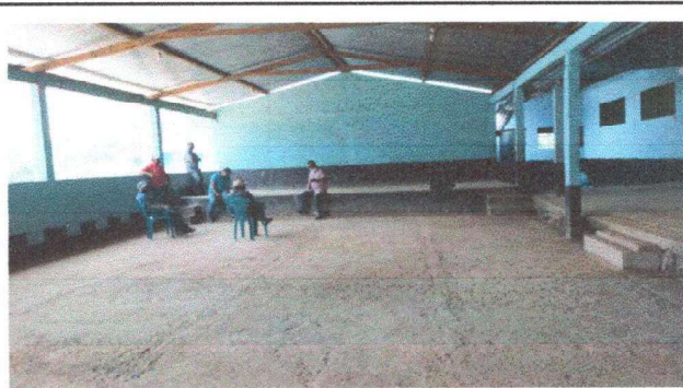
FOTO 2 MODULO 2 SUSTITUCION DE ESTRUCTURA DE MADERA A METAL
