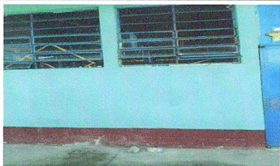
Foto 1: MODULO 4 sustitucion de vidrios
