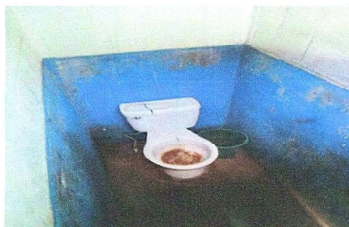
Foto 4: MODULO 4 Sustitucion de inodoro
