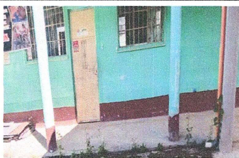
Foto 2: MODULO 2 reparacion de banqueta de concreto
