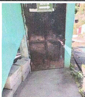
Foto 3 MODULO 3 sustitucion de puerta
