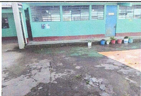
Foto 5: PATIO sustitucion de piso de torta de concreto
