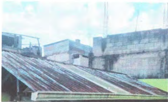
FOTO 1 MODULO 4 SUSTITUCION DE LAMINA DE METAL
