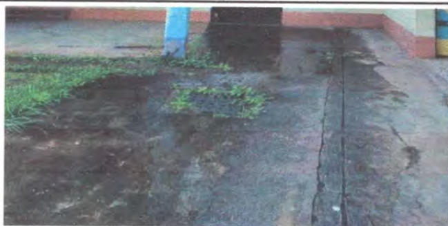
FOTO 1 PATIO REPARACION DE PLANCHAS DE CONCRETO DE PATIO
