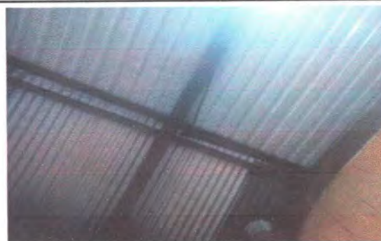
FOTO 6 MODULO 3 SUSTITUCION DE SOPORTE DE MADERA POR METAL
