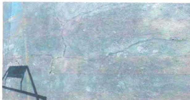
FOTO 2 PATIO REPARACION DE PLANCHAS DE CONCRETO DE PATIO
