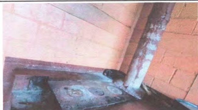
FOTO 1 MODULO 3 sustitucion de estufa rural
