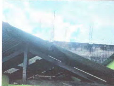
FOTO 2 MODULO 4 SUSTITUCION DE PORTANTE DE METAL
