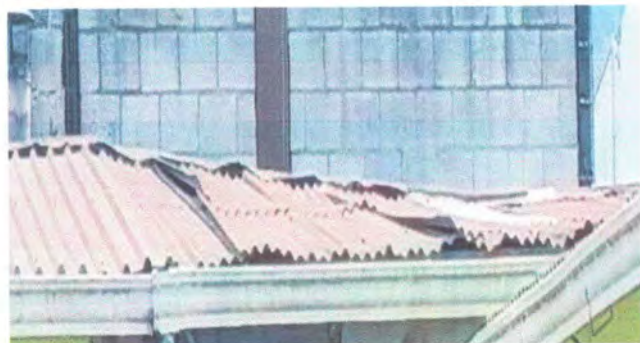
FOTO 5 MODULO 3 SUSTITUCION DE LAMINA DE METAL
