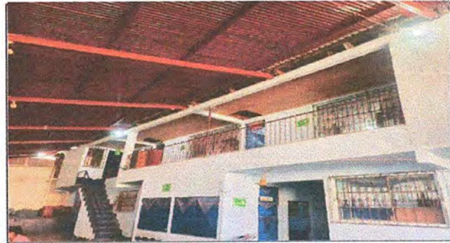
Foto 6: Modulo 4. Mantenimiento de barandas de metal
