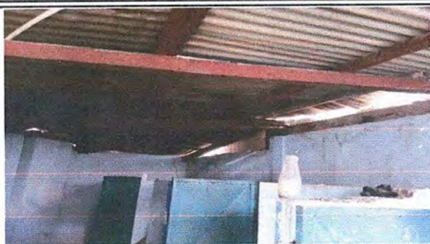
Foto 1: Modulo 1. Sustitución de lamina por lámina troquelada aluzinc 26
