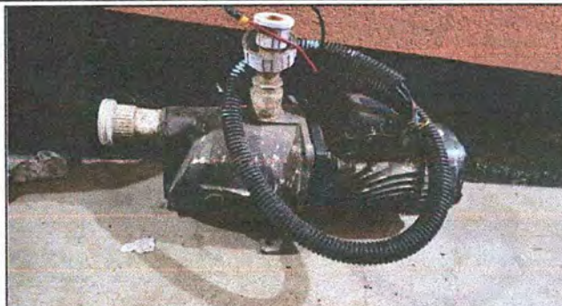
Foto 8: Modulo 5 sustitución de bomba de agua
