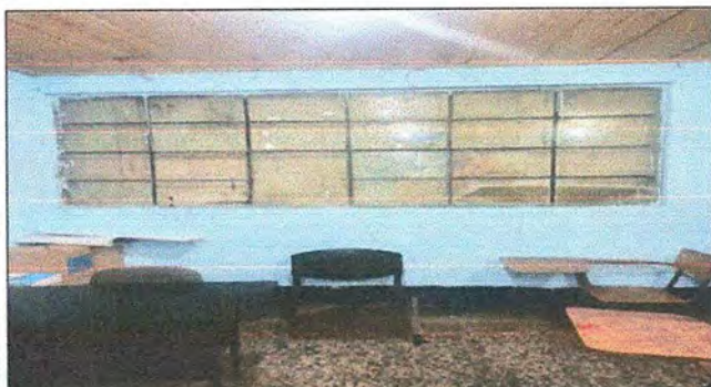
Foto 3: Modulo 2. Sustitución de estructura de metal de ventana
