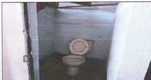
Foto 5: Modulo 3. Sustitución de 2 inodoros
