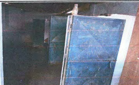
Foto 2: Modulo 1. Sustitución de puertas de Sanitarios
