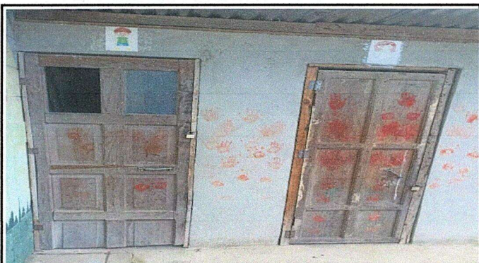
Foto 3: Módulo 3 Sustitución de puertas de Metal en Baños.
