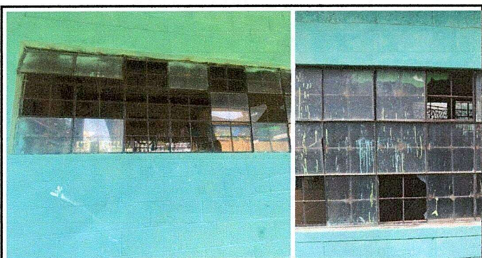
Foto 5: Módulo 5 Sustitución de vidrios
