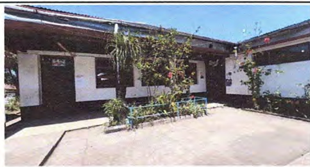
Foto 8: Modulo 2. Instalación de canal de metal. Pintura en muros exteriores e interiores
