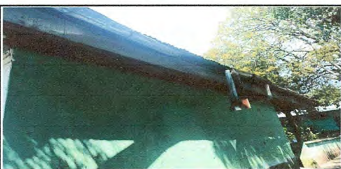
Foto 6: Modulo 2. Sustitución de soporte o pescante de metal para canal
