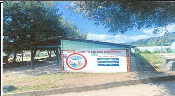
Foto 2: Modulo 1. Sustitución de capote de lámina para lámina troquelada. Desinstalación de lámina existente. Instalación de lámina troquelada aluzinc calibre 26.
