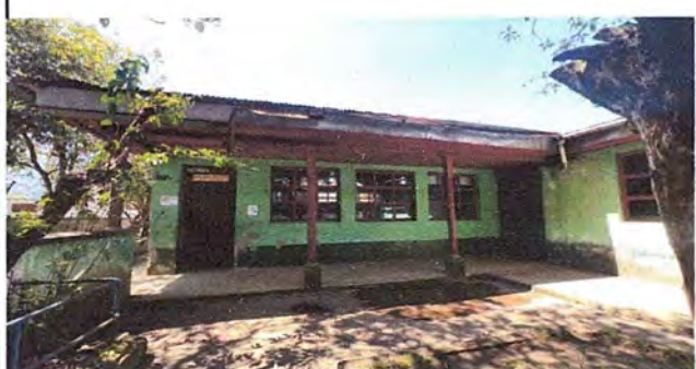
Foto7: Modulo 2. Instalación de canal de metal. Pintura en muros exteriores e interiores
