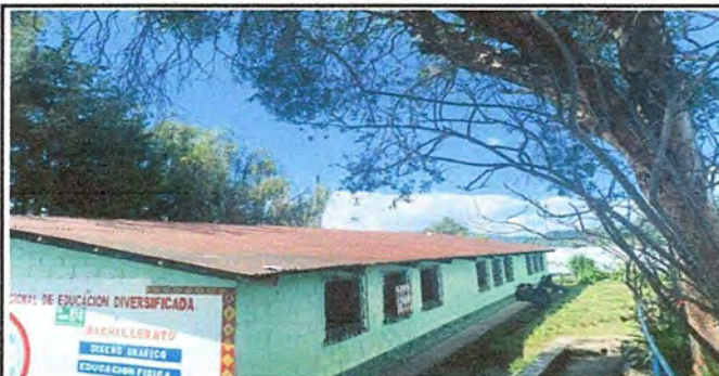
Foto1: Modulo 1. Sustitucionde lamina por lamina troquelada aluzinc calibre 26. Sustitución de elementos de fijación (tornillos)
