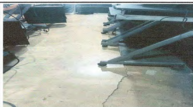
Foto 4: Modulo 2. Sustitución de torta de cemento por piso ceramico (incluye retiro de torta de concreto existente por daños de raíz de arbol)
