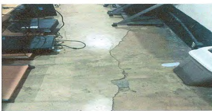
Foto 5: Modulo 2. Sustitución de torta de cemento por piso ceramico (incluye retiro de torta de concreto existente por daños de raíz de arbol)
