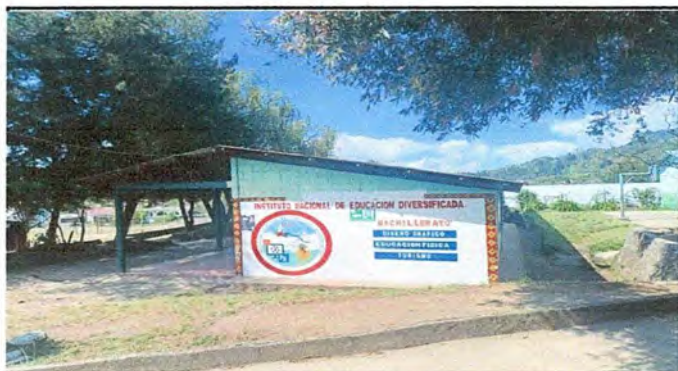
Foto 3: Modulo 1. Pintura en muros exteriores e interiores.
