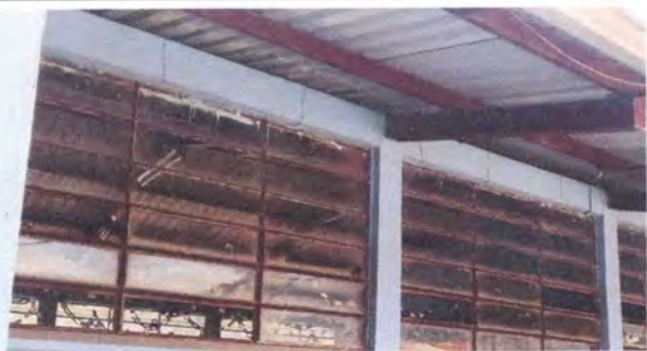
FOTO 1 MODULO 2 MANTENIMIENTO A ESTRUCTURA DE METAL DE VENTANA
