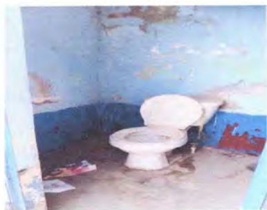
FOTO 5 MODULO 3 SUSTITUCION DE INODORO
