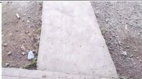
FOTO 8 REPARACION DE PLANCHAS DE CONCRETO DE PATIO
