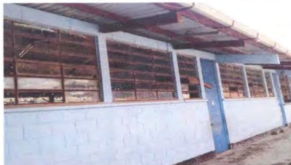
FOTO 2 MODULO 2: SUTITUCION DE VIDRIOS
