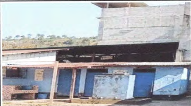
FOTO 3 MODULO 3 SUSTITUCION DE LAMINAS DE METAL
