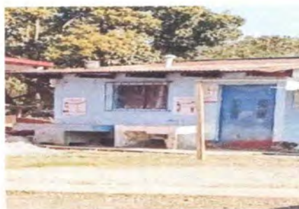
FOTO 6 MODULO 4 SUSTITUCION DE LAMINA DE METAL
