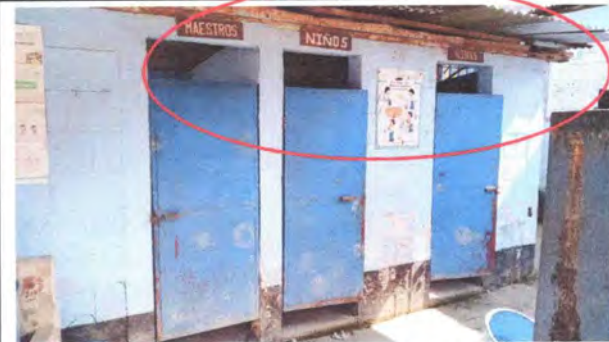
FOTO 4 MODULO 3 SUSTITUCION DE ESTRUCTURA DE METAL
