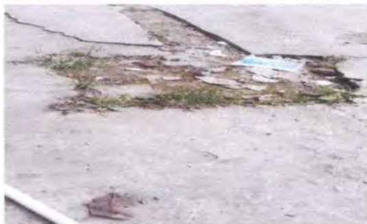
FOTO 7 REPARACION DE PLANCHAS DE CONCRETO DE PATIO
