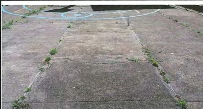
Foto 3: Reparación de planchas de concreto de patio
