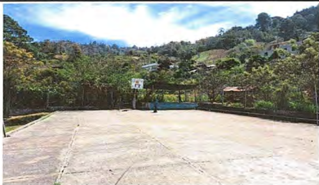
Foto 1: Reparación de planchas de concreto de patio
