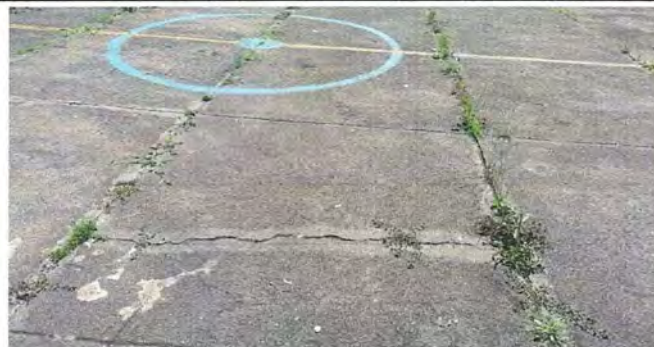
Foto 4: Reparación de planchas de concreto de patio
