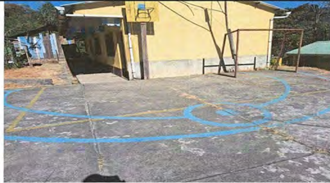
Foto 2: Reparación de planchas de concreto de patio
