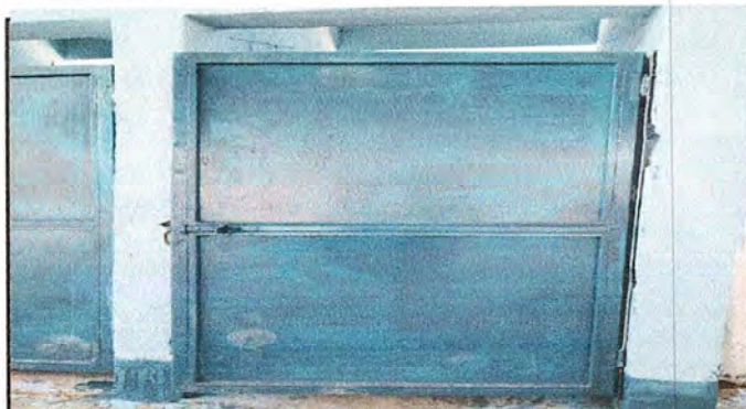
Foto 3 fabricación e instalación de puerta de metal en baño
