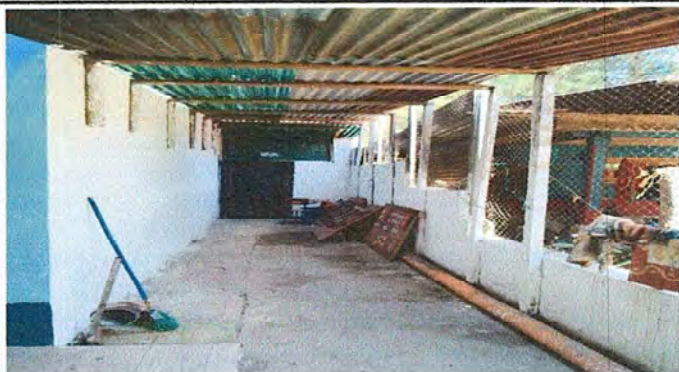
Foto1: sustitución de estructura de soporte de madera por metal modulo 2
