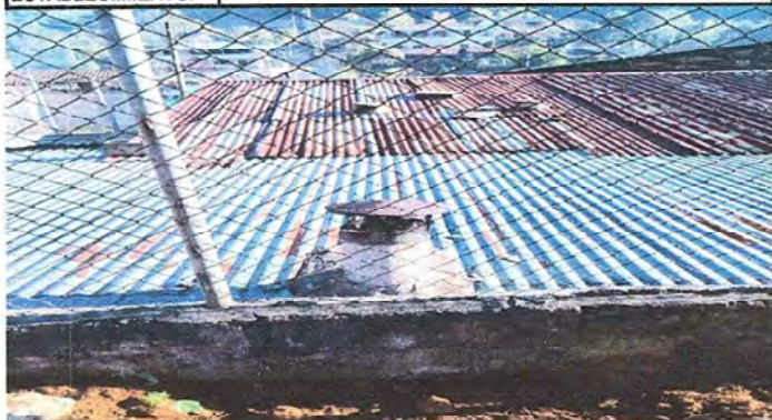
Foto1: sustitución de lamina por lámina troquelada aluzinc calibre 26
