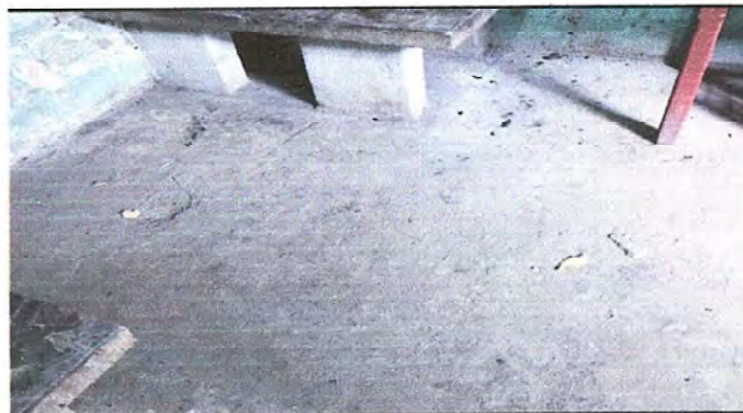
Foto 4: sustitución de torta de concreto por ceramico modulo 1
