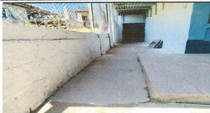
Foto2: sustitución de estructura de soporte de madera por metal modulo 3
