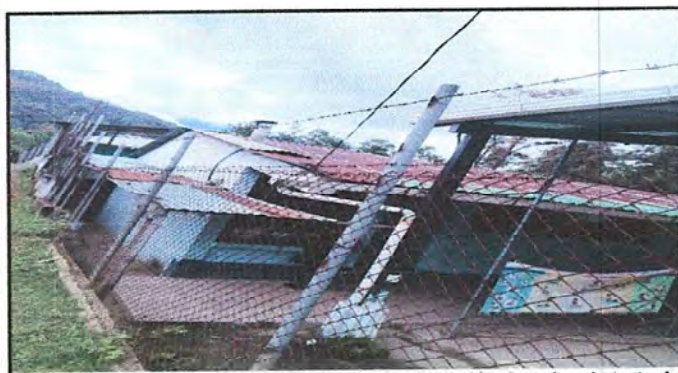
Foto 5: Sustitución de lamina troquelada y sustitución de puiso de torta de cemento por ceramico modulo 3
