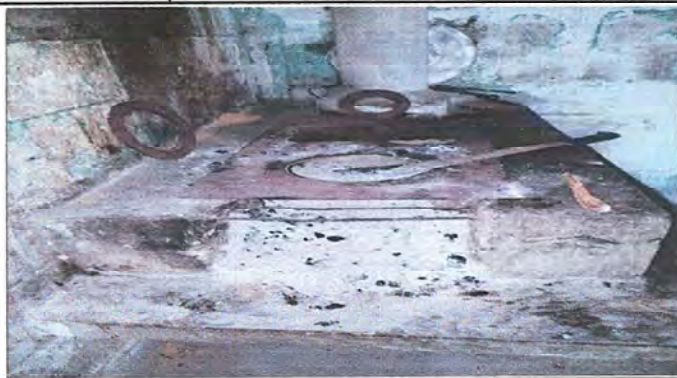
Foto2: sustitución de estufas rurales(completas) incluye chimeneas y planchas de metal
