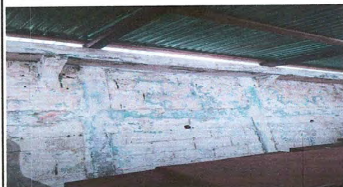
Foto 3:reparación de repello de cernido de pared modulo 1
