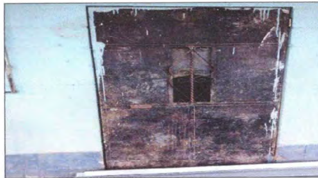
FOTO 4 MODULO 1 SUSTITUCION DE PUERTA
