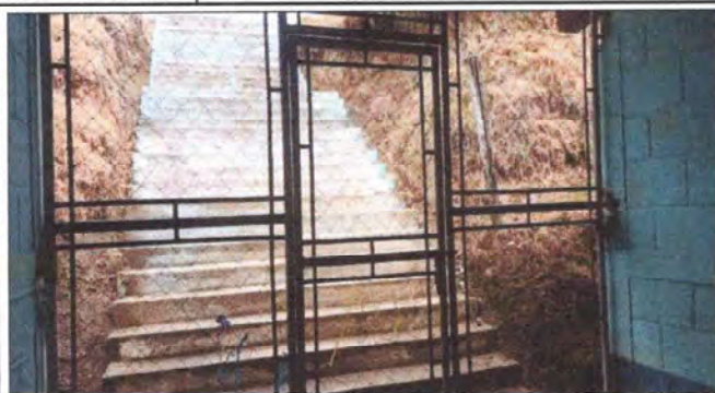
FOTO 1 MANTENIMIENTO PORTON DE METAL
