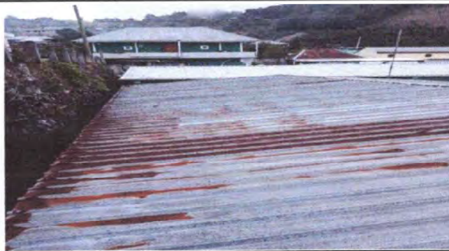
FOTO 2 MODULO 1 SUSTITUCION DE LAMINA DE METAL
