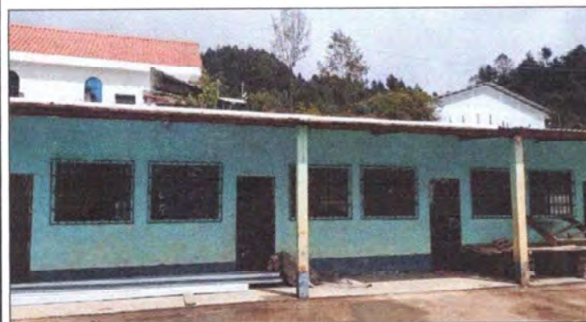
FOTO 3 MODULO 1 SUSTITUCION DE CANAL PVC
