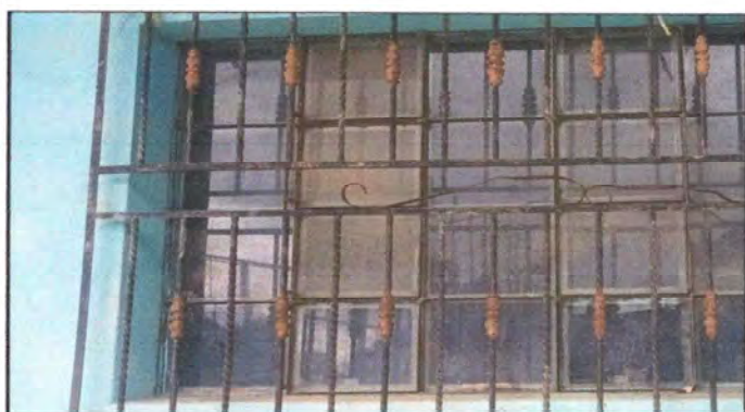
FOTO 9 MODULO 4 SUSTITUCION DE BALCONES DE METAL
