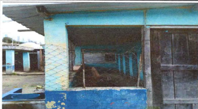
FOTO 7 MODULO 3 REPARACION DE TUBO HG Y MALLA GALVANIZADA
