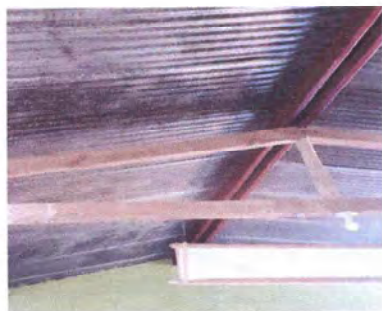
FOTO 7 MODULO 4 SUSTITUCION DE LAMINA DE METAL
