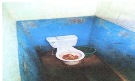
FOTO 10 MODULO 5 SUSTITUCION DE INODORO
