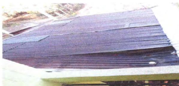
FOTO 4 MODULO 3: SUSTITUCION DE LAMINA DE METAL
