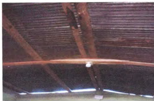
FOTO 2 MODULO 1: SUSTITUCION DE ESTRUCTURA DE METAL
