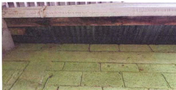
FOTO 8 MODULO 4 SUSTITUCION DE CANAL
