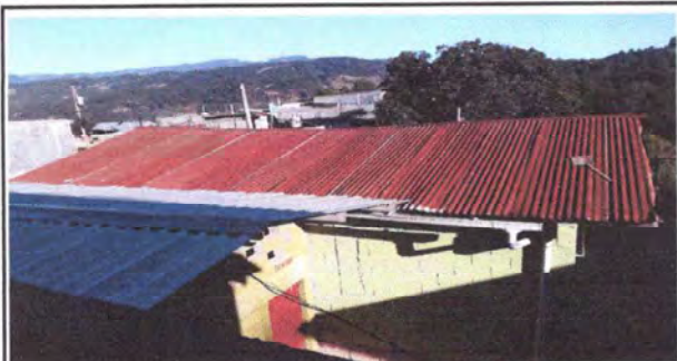
FOTO 1 MODULO 1: SUSTITUCION DE LAMINA DE METAL
