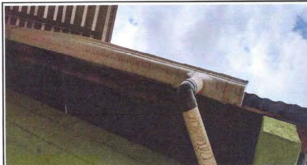
FOTO 3 MODULO 1: SUSTITUCION DE CANAL PVC
