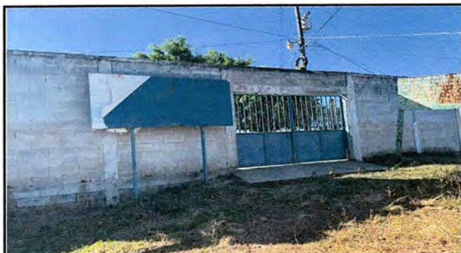
Foto 9: PINTURA GENERAL Aplicación de pintura de muro perimetral interiores y exteriores
