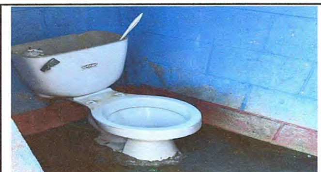
Foto 6: BAÑO Sustitución de Inodoros
