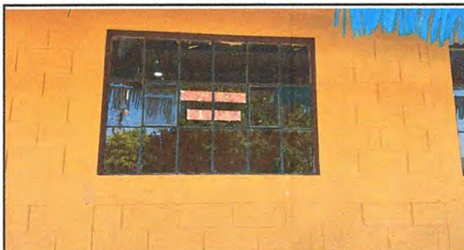
Foto 3: MODULO 1 Sustitución de ventana de metal por PVC
