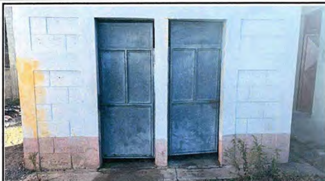
Foto 7: BAÑOS Sustitución de puertas de metal
