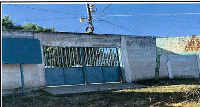
Foto 10: MURO PERIMETRAL Mantenimiento a estructura de porton (lijado, cambio de tubo, cepillado, sujeciones, aplicación de pintura).
