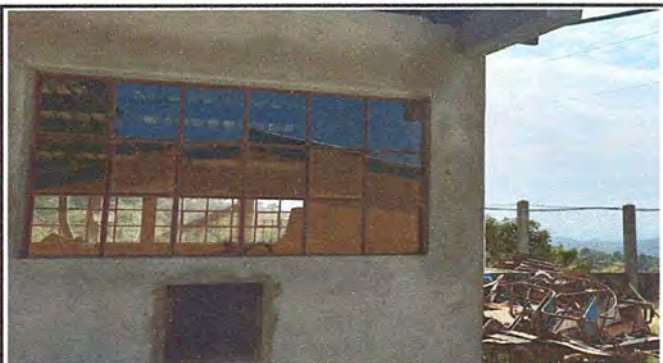
Foto 4: MODULO 2 Sustitución de balcones de metal
