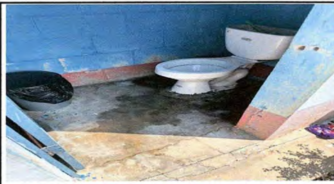
Foto 8: BAÑOS Sustitución de piso de torta de concreto por piso cerámico
