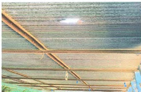
Foto 25: PATIO: Desinstalación de lámina existente e instalación de lámina troquelada aluzinc calibre 26.
