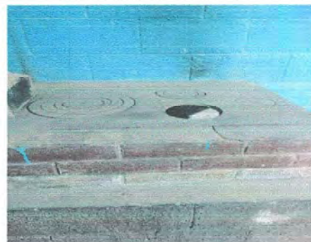
Foto 10: MÓDULO 3: Sustitución de plancha de metal de 3 hornillas.
