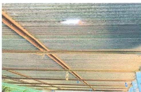
Foto 22: PATIO: Sustitución de lámina, por lámina troquelada aluzinc calibre 26.
