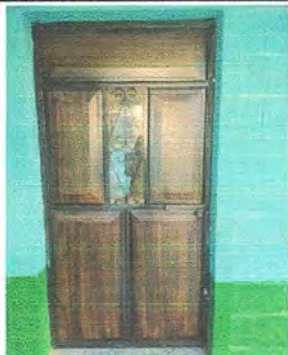
Foto 1: MÓDULO 1: Sustitución de Chapa.
