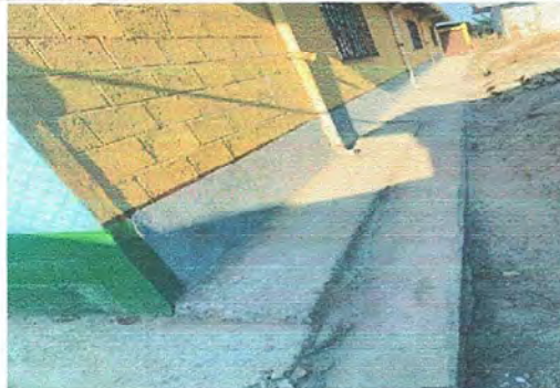
Foto 4: MÓDULO 1: Reparación de banquetas de concreto.
