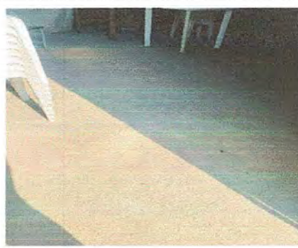
Foto 16: MÓDULO 4: Sustitución de piso de torta de concreto por piso de granito.
