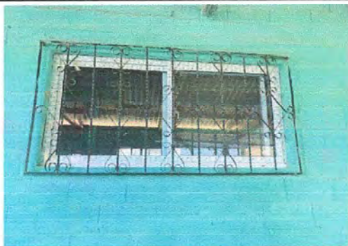
Foto 3: MÓDULO 1: Mantenimiento a balcones de metal.
