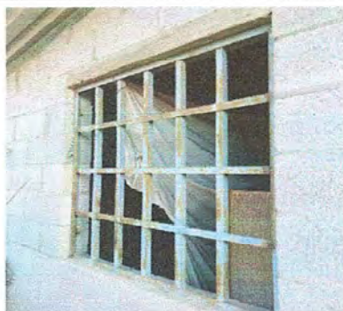
Foto 15: MÓDULO 4: Sustitución de balcón de metal.
