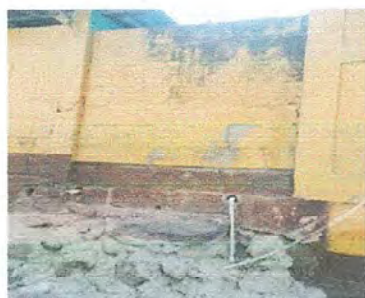
Foto 27: PATIO: Reparación de muro perimetral de block.
