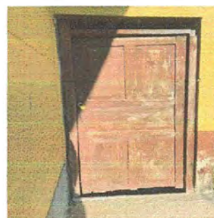
Foto 12: MÓDULO 3: Sustitución de puerta de madera por puerta de metal.
