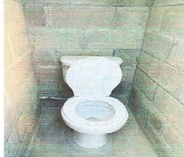
Foto 6: MÓDULO 2: Sustitución de azulejos.
