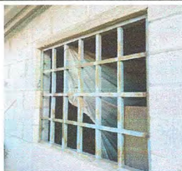
Foto 14: MÓDULO 4: Sustitución de ventana de metal por pvc más vidrio.
