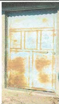
Foto 13: MÓDULO 4: Mantenimiento a estructura de puerta (lijado, cepillado y aplicación de pintura).
