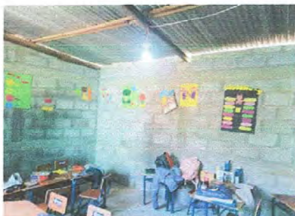
Foto 19: MÓDULO 5: Repello en muro
