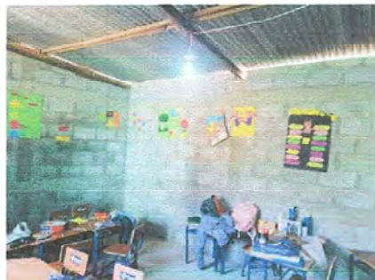
Foto 20: MÓDULO 5 : Pintura en muros exteriores e interiores
