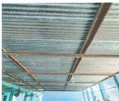
Foto 23: PATIO: Sustitución de estructura de soporte de metal, por metal.
