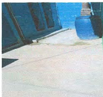
Foto 21: PATIO: Reparación de plancha de concreto de patio.
