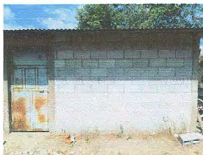
Foto 17: MÓDULO 4: Repello en muro.
