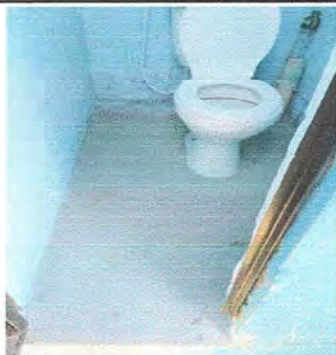
Foto 7: MÓDULO 2: Sustitución de piso de torta de concreto por piso cerámico antideslizante.
