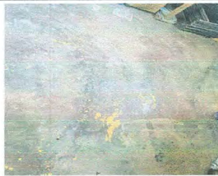
Foto 2: MÓDULO 1: Sustitución de piso de torta de concreto por piso de granito.
