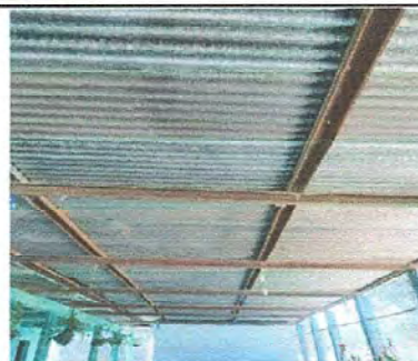
FOTO 26: PATIO: Desinstalación de estructura portante de metal e instalación de estructura de metal.
