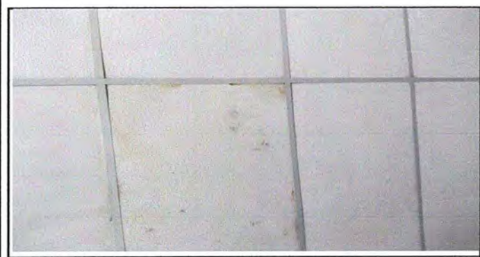
Foto 5: Módulo 1, Sustitución de plancha de cielo falso.
