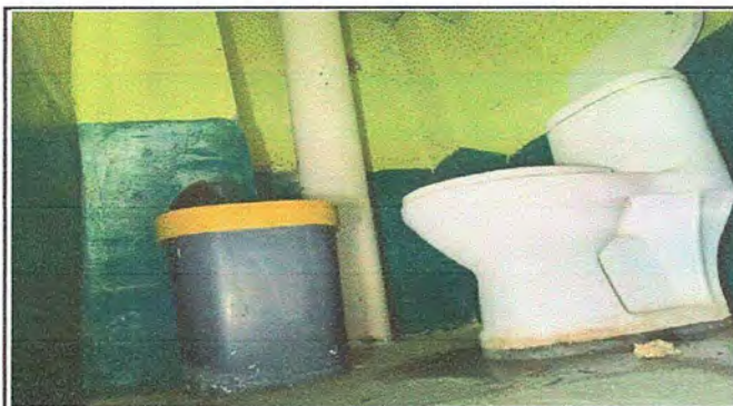
Foto 10: Módulo 2, Sustitución de inodoros y tubería de drenaje.
