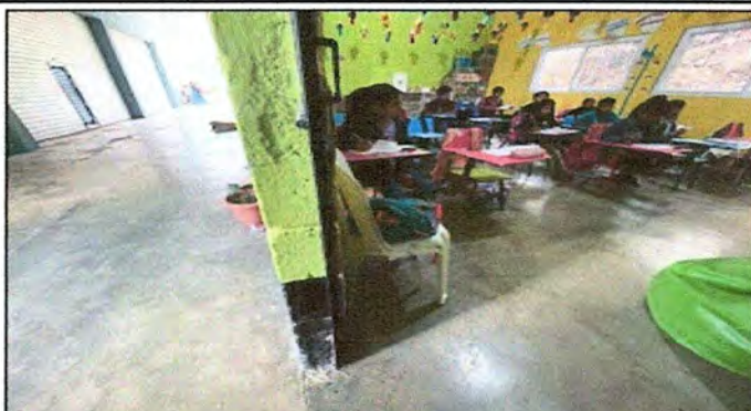
Foto 2: Módulo 1, Sustitución de piso de torta de concreto por piso de granito.
