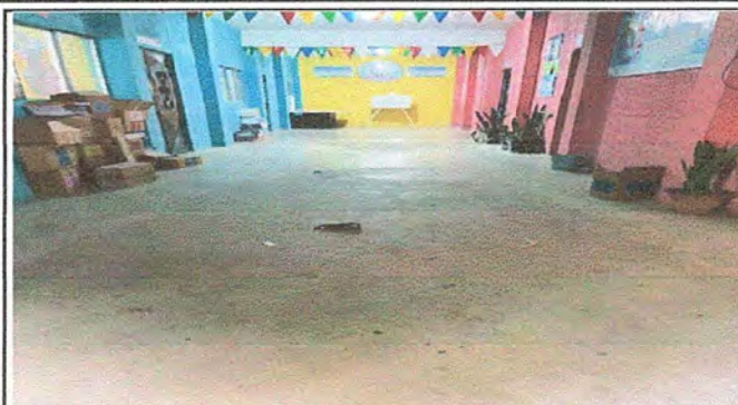
Foto 7: Módulo 2, Sustitución de piso de torta de concreto por piso cerámico.
