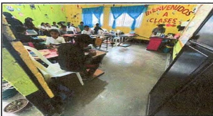
Foto 4: Módulo 1, Sustitución de piso de torta de concreto por piso de granito.
