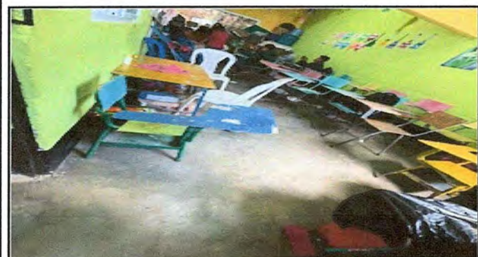
Foto 3: Módulo 1, Sustitución de piso de torta de concreto por piso de granito.
