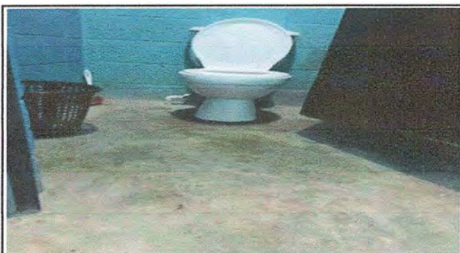
Foto 9: Módulo 2, Sustitución de inodoros y tubería de drenajes.
