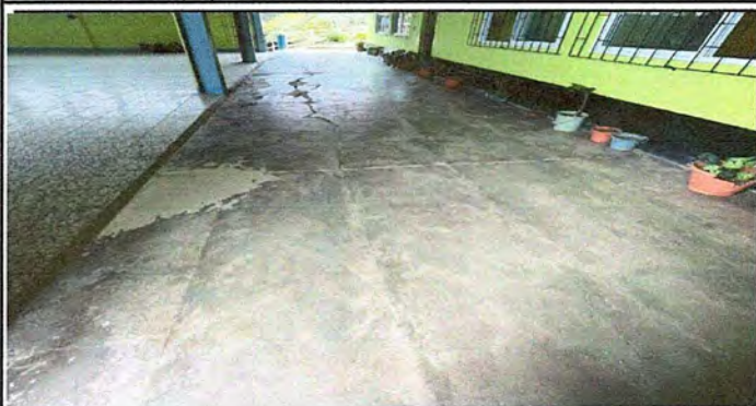
Foto 1: Módulo 1, Sustitución de piso de torta de concreto por piso de granito.
