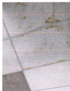
Foto 2: MÓDULO 1: SUSTITUCIÓN DE PLANCHA CIELO FALSO
