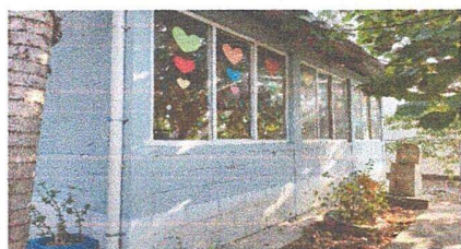
Foto 3: MÓDULO 1: PINTURA EN MUROS EXTERIORES E INTERIORES
