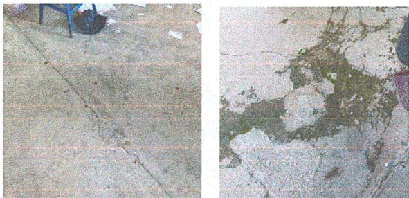
Foto 1: MÓDULO 1: SUSTITUCIÓN DE PISO DE CEMENTO LÍQUIDO POR PISO CERÁMICO
