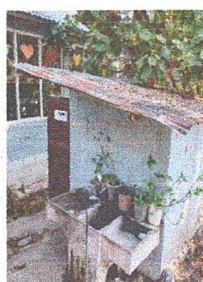
Foto 6: MÓDULO 2-SANITARIO: SUSTITUCIÓN DE LÁMINA, POR LÁMINA TROQUELADA ALUZINC CALIBRE 26, SUSTITUCIÓN DE ELEMENTOS DE FIJACIÓN (TORNILLOS) Y SUSTITUCIÓN DE PILA PLÁSTICA DE 2 LAVADEROS
