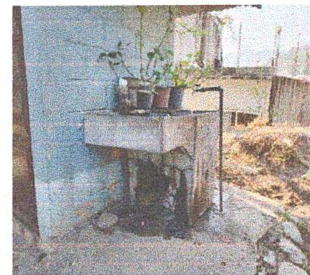
Foto 6: MÓDULO 2-SANITARIO: SUSTITUCIÓN DE LÁMINA, POR LÁMINA TROQUELADA ALUZINC CALIBRE 26, SUSTITUCIÓN DE ELEMENTOS DE FIJACIÓN (TORNILLOS) Y SUSTITUCIÓN DE PILA PLÁSTICA DE 2 LAVADEROS
