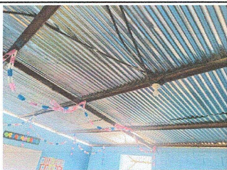
Foto 5. Modulo 2: Sustrucion de estructura de soporte de metal por metal
