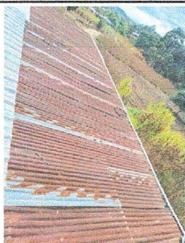
Foto 1. Modulo1: Sustrucion de lamina por lamina troquelada calibre 26
