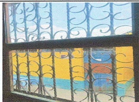
Foto 6. Modulo 2: Sustrucion de ventanas de madera por metal más vidrios.
