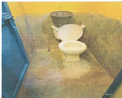
Foto 3. Modulo 2: Sustitución de inodoros y azulejo.
