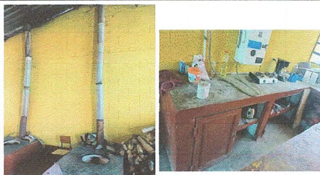
Foto 2. Modulo 1: instalación de azulejo en estufa rural y mueble de concreto de cocina.
