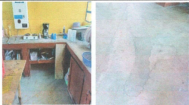
Foto 1. Modulo 1: Sustitución de piso de concreto por piso cerámico.
