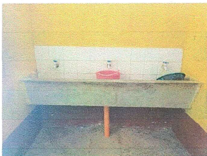
Foto 5. Modulo 2: Sustitución de llaves en mingitorios y azulejo.
