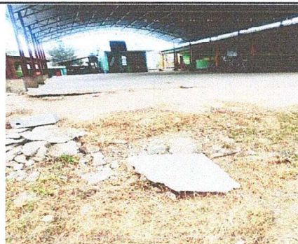
Modulo 2: Sustitucion de piso de torta de concreto (patios).
