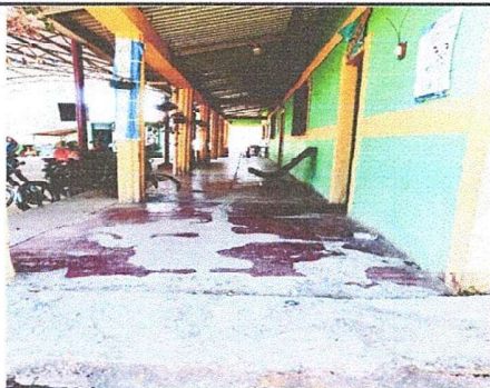
Modulo 1: Sustitucion de piso de torta de concreto (aulas).
