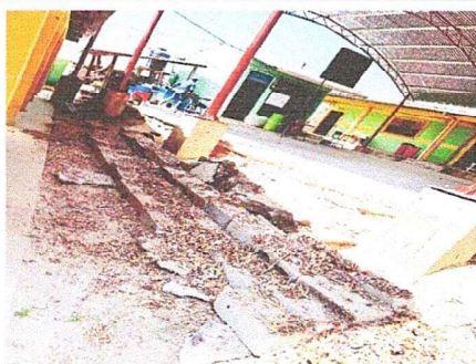
Modulo 3: Reparación de Gradadas de Concreto (gradas).
