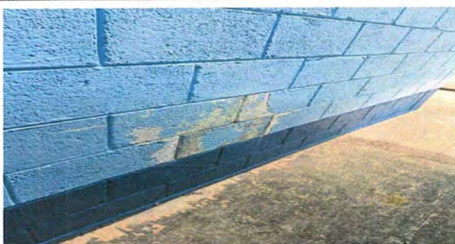
MODULO 1: FOTO 3 Aplicación de pintura en muro exteriores e interiores
