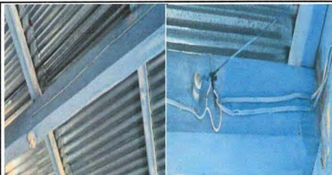
MODULO 1: FOTO 4 Instalacion de de unidades de luz
