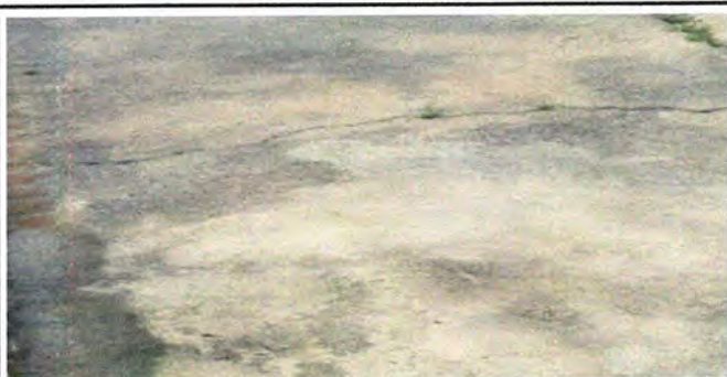
MODULO 1: FOTO 5 Sustitucion de piso de torta de concreto
