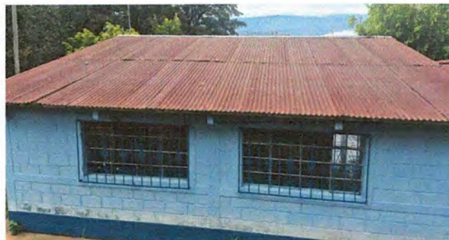
MODULO 1: FOTO 2 Instación de lamina por lamina troquelada alusing cal. 26
