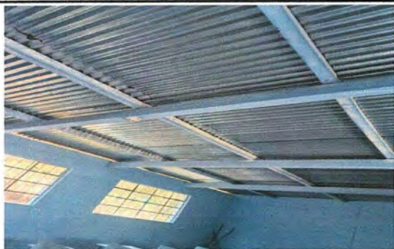
MODULO 1: FOTO 1 Sustitucion de estructura de soporte de madera por metal
