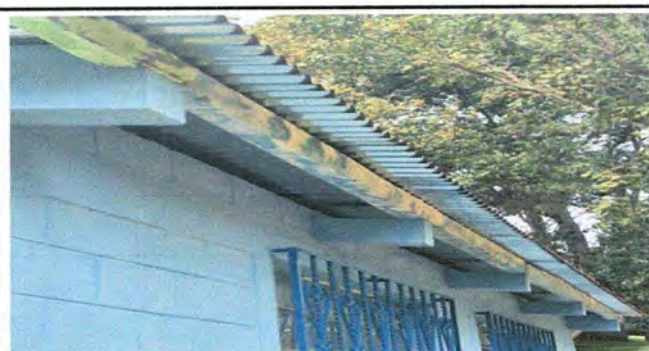
MODULO 1: FOTO 6 Sustitucion de canal de metal
