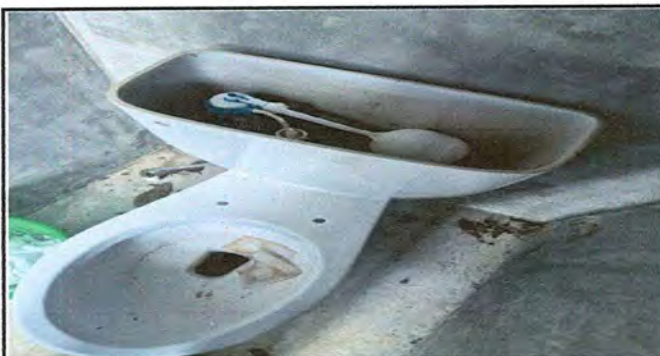
MODULO 3: FOTO 9 Sustitucion de inodoro
