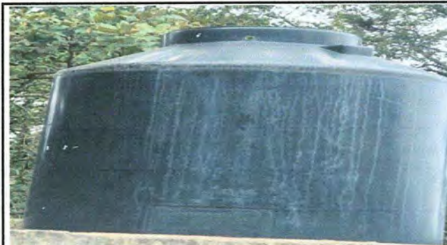
MODULO 3: FOTO 10 Sustitución de depocito de agua de 1100Lt
