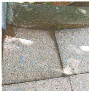
Foto 2: MÓDULO 1: SUSTITUCIÓN DE PISO DE GRANITO
