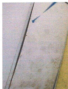
Foto 4: MÓDULO 1: SUSTITUCIÓN DE PLANCHA CIELO FALSO
