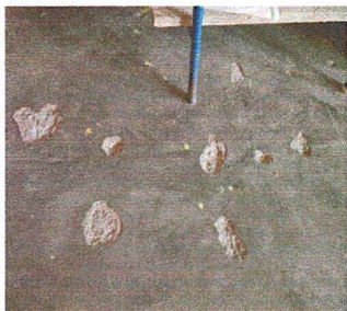
Foto 1: MÓDULO 1: SUTITUCIÓN DE PISO DE CEMENTO LÍQUIDO POR PISO CERÁMICO
