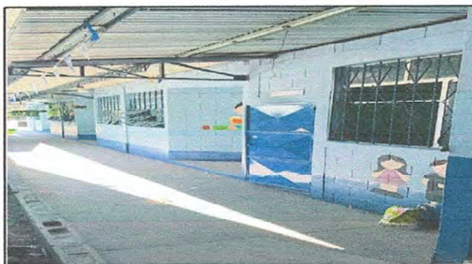
Foto 3: Módulo 2: sustitución de balcones
