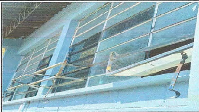
Foto 2: Módulo 1: sustitución de estructura de metal de ventana
