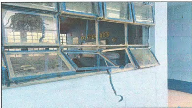
Foto 4: Módulo 2: sustitución de estructura de metal de ventana
