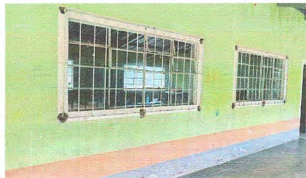
Foto 8: Pintura en muros exteriores e interiores
