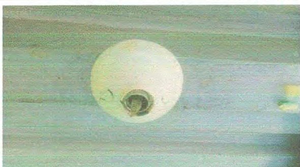
Foto 11: Sustrucción de focos ahorradores
