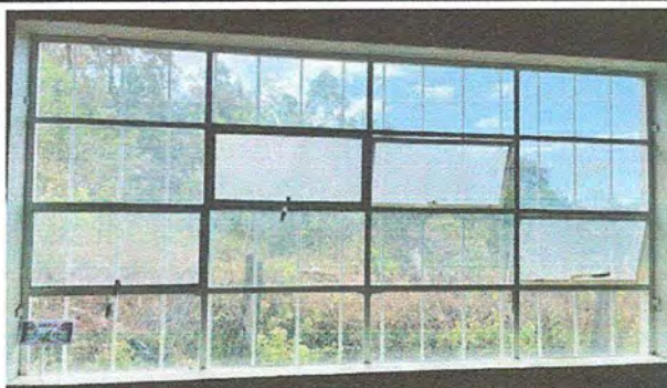
Foto 3: Sustitución de estructura de metal de ventana
