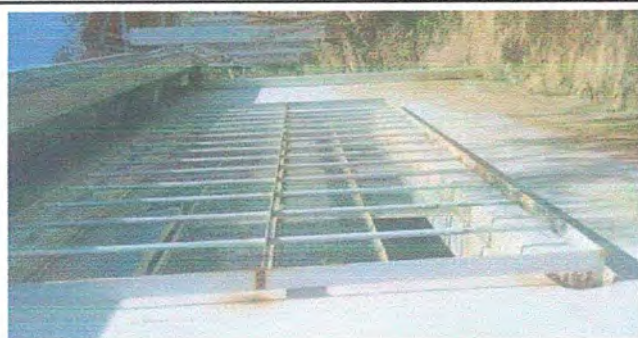
Foto 5: Mantenimiento a balcones de metal
