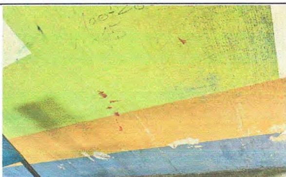
Foto 9: Pintura en muros exteriores e interiores
