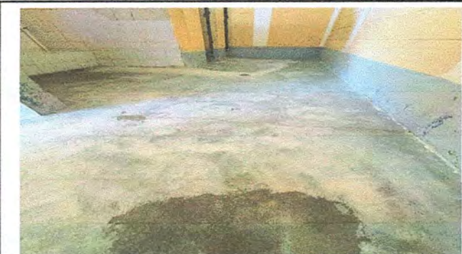
Foto 5: Modulo 2. Sustitución de piso de concreto a piso ceramico
