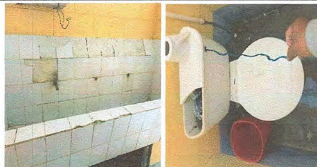
Foto 4: Modulo 2 Sustitucion de piso (azulejo), Sustitución de Inodoro.
