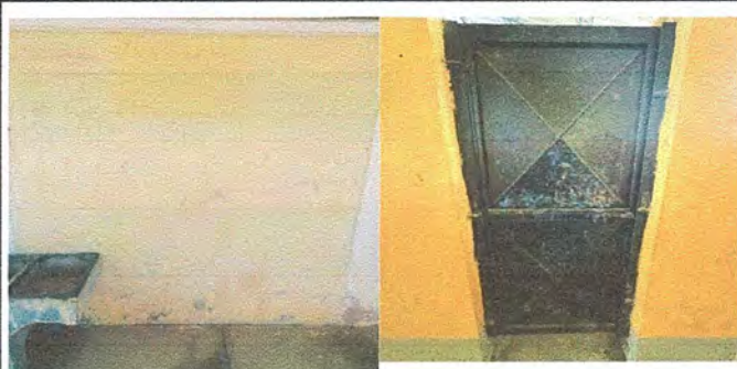
Foto 3: Modulo 2: Pintura en muros exteriores e interiores, Mantenimiento a estructura de puerta (lijado, Sujeciones, Aplicación de pintura)
