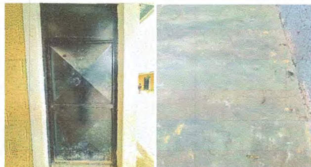
Foto 2 : modulo:1 Mantenimiento a estructura de puerta (lijado, Sujeciones, Aplicación de pintura), Sustitución de piso de concreto por piso ceramico
