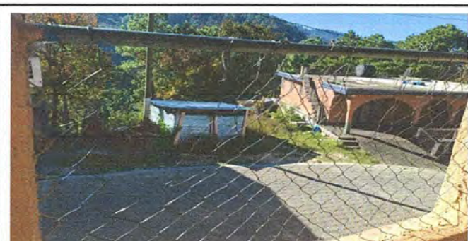
Foto 6. MURO PERIMETRAL: REPARACION DE TUBO GH Y MALLA GALVANIZADA
