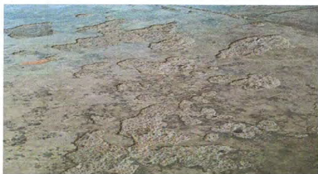
FOTO 1. MODULO 1: SUSTITUCION DE PISO CONCRETO POR PISO CERAMICO
