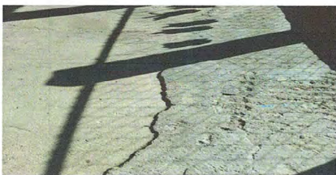
FOTO 3. PATIO: SUSTITUCION DE PISO DE CONCRETO
