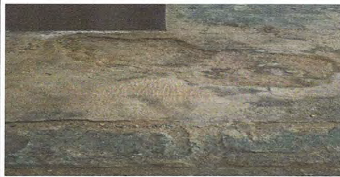
FOTO 4. PATIO: SUSTITUCION DE PISO DE CONCRETO
