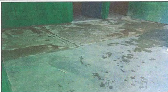
Foto 1: Módulo 1. Sustitución de piso de torta de cemento por piso cerámico antideslizante.
