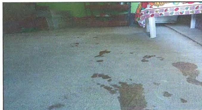
Foto 4: Módulo 1. Sustitución de piso de torta de concreto por piso cerámico en cocina y dos aulas.
