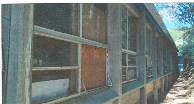
Foto 5: Módulo 1. Sustitución de vidrios, EORM.
