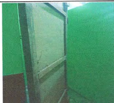
Foto 11: Módulo 1. sustitución de puerta de metal en baños.
