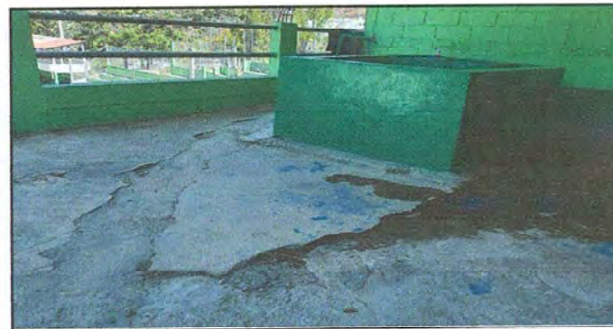
Foto 6: Módulo 1. Reparación de planchas de concreto de patio.
