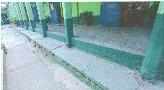
Foto 3: Módulo 1. Reparación de piso de torta de concreto.
