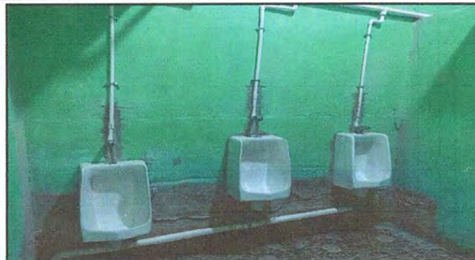
Foto 2: Módulo 1. Sustitución de zulejo.
