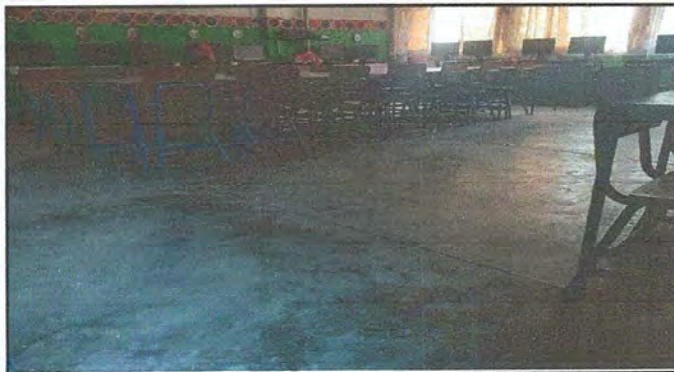
Foto 8: Módulo 1. Sustitución de torta de cemento por piso cerámico en aulas.
