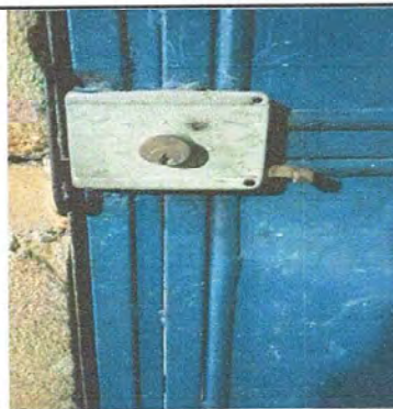
Foto 10: Módulo 1. Sustitución de Chapa Yale.
