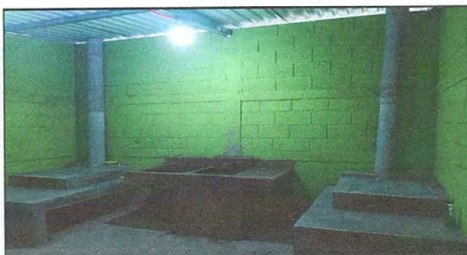
Foto 9: Módulo 1. Suministro e instalación de azulejo.
