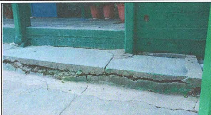
Foto 7: Módulo 1. Reparación de banqueta de concreto.
