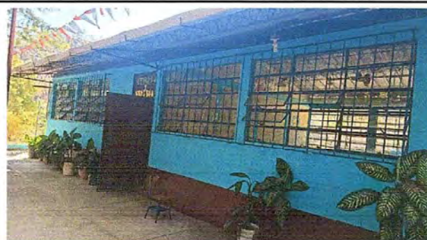
Foto 16: Módulo 4, Sustitución de ventanas de metal por PVC más vidrio.
