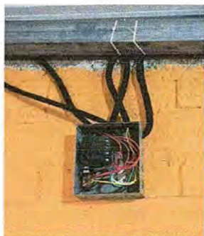
Foto 13: Módulo 3, Sustitución de tablero de flipones
