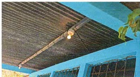
Foto 7: Módulo 1, Sustitución de lámparas tipo LED
