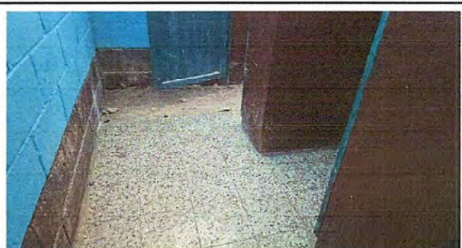
Foto 4: Módulo 1, Sustitución de piso de granito por cerámico antideslizante
