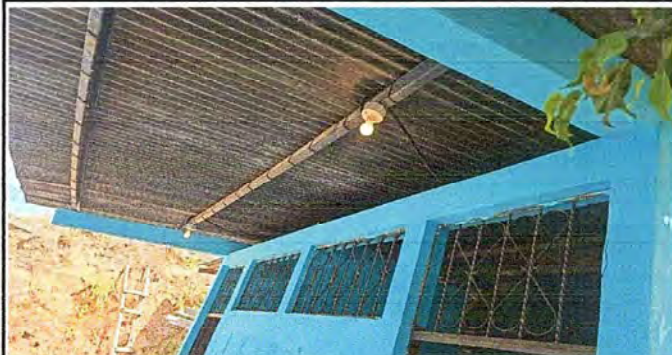
Foto 2: Módulo 1, Sustitución de estructura de soporte de metal, por metal.
