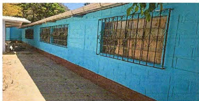
Foto 8: Módulo 2, Sustitución de ventanas de metal por PVC mas vidrio.
