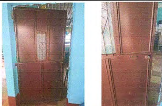
Foto 9: Módulo 2, sustitución de chapa.
