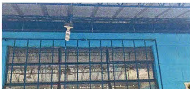
Foto 15: Módulo 4, Sustitución de lámparas tipo LED
