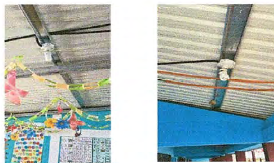
Foto 10: Módulo 2, Sustitución de lámparas tipo LED
