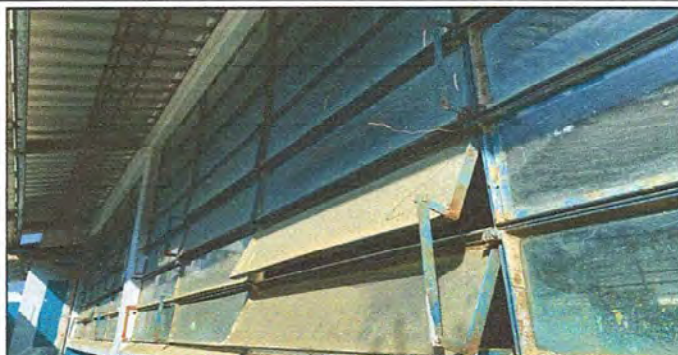
Foto 2: Modulo 2: Sustitución de estructura de metal de ventana
