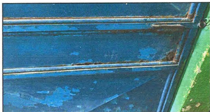
Foto 5: Baños: Puertas de los baños en mal estado, deteioradas y oxidadas
