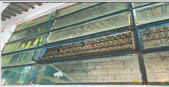
Foto 1: Modulo 1: Sustitución de estructura de metal de ventana
