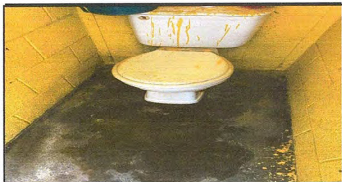
Foto 3: Baños: Sustitución de Inodoros
