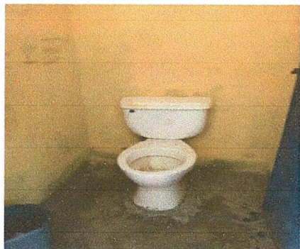
Foto 1 Módulo I: Sustitución de inodoros.
