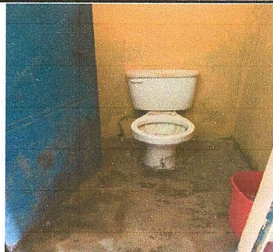
Foto 2 Módulo I: Mantenimiento en estructura de puertas (lijado, cambio de tubo, cepillado, sujeciones y aplicación de pintura).
