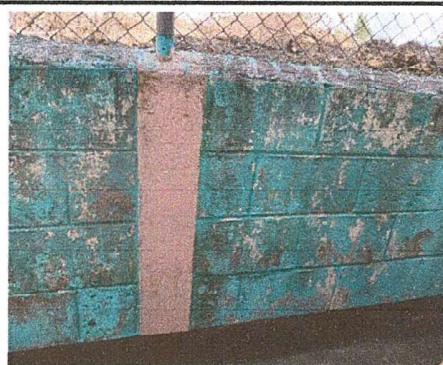
Foto 4 Módulo II: Pintura en muros exterior e interior.
