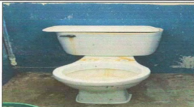
FOTO 7: MODULO 3 SUSTITUCION DE ACCESORIOS INODORO (CONTRALLAVE, TUBO DE ABASTO Y TANQUE)
