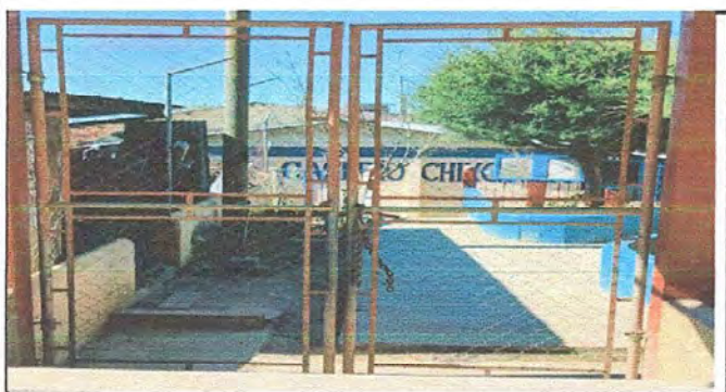
Foto 3 : MODULO 1: SUSTITUCION DE PORTON DE METAL
