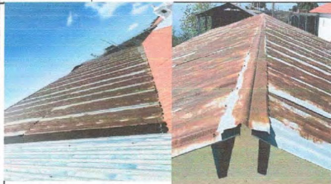
FOTO 1: MODULO 1: SUSTITUCION DE LAMINA Y SUSTITUCION DE CAPOTE DE LAMINA TROQUELADA
