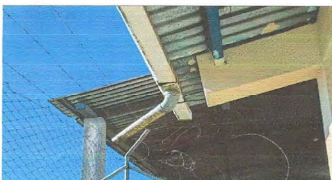
FOTO 4 : MODULO 1: SUSTITUCION DE SOPORTE O PESCANTE DE METAL PARA CANAL
