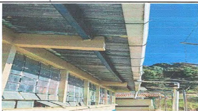
Foto 2 : MODULO 1: SUSTITUCION DE CANAL DE PVC
