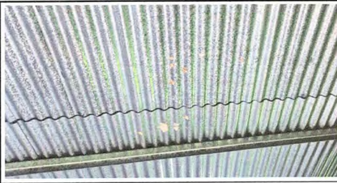
MODULO 2: FOTO 12 SUSTITUCION DE LAMINA POR LAMINA TROQUELADA ALUSING CAL. 26
