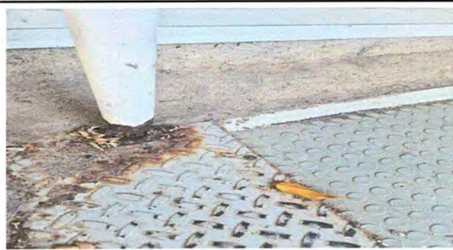
MODULO 1: FOTO 2 MANTENIMIENTO A VARANDA DE METAL
