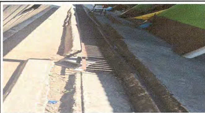
MODULO 2: FOTO 8 REPARACION DE CUNETA Y REGILLA
