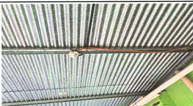
MODULO 2: FOTO 9 DESINSTALACION DE LAMINA EXISTENTE
