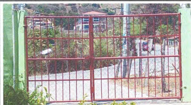
MURO PERIMETRAL: FOTO 16 SUSTITUCION DE PORTON DE METAL DE INGRESO
