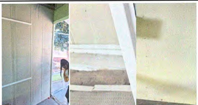
MODULO 1: FOTO 5 APLICACIÓN DE PINTURA EXTERIORES E INTERIORES
