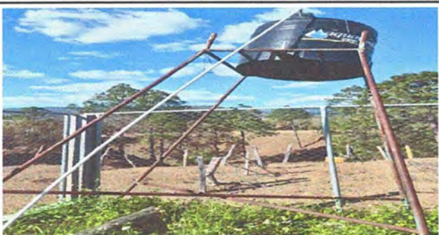
AREA EXTERIOR: FOTO 15 SUSTITUCION DE DEPOSITO DE AGUA Y ESTRUCTURA DE BASE
