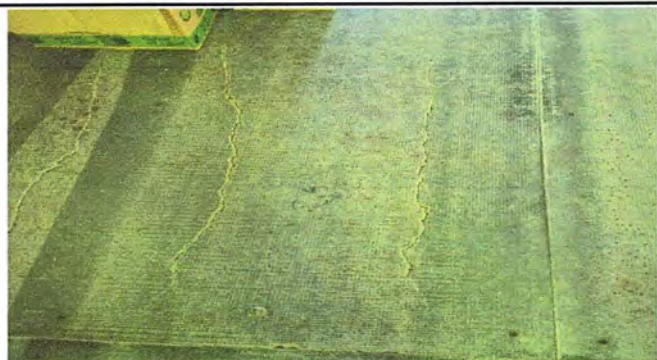
MODULO1: FOTO 1 SUSTITUCIÓN DE PISO VINIL
