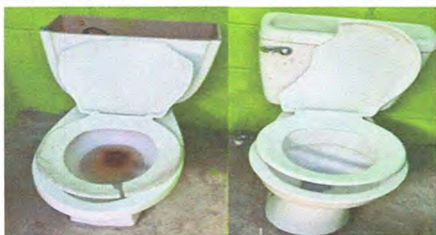
AREA EXTERIOR: FOTO 13 SUSTITUCION E INSTALACION DE INODORO
