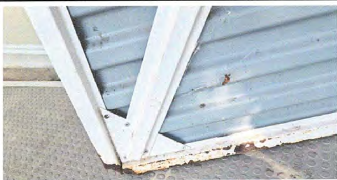
MODULO 1: FOTO 3 MANTENIMIENTO A ESTRUCTURA DE PUERTA DE METAL
