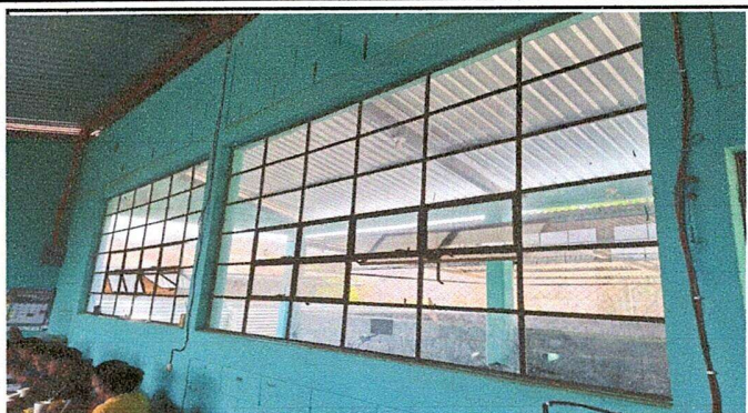
MODULO1: Sustitución de vidrios e instalación de balcones. Así mismo pintura del modulo.
