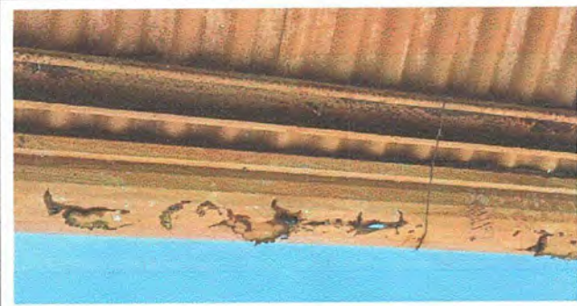
Foto 6: Módulo 1. Sustitución de canales
