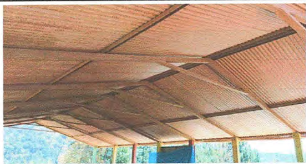
Foto 5: Módulo 1. Sustitución del techado de lámina
