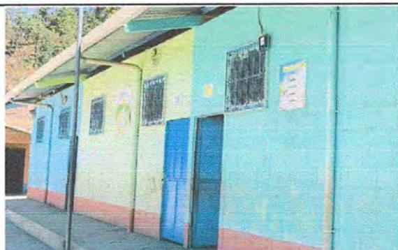
Foto 3: Módulo 1: Sustitución de estructura de metal de ventana (Incluye vidrios)
