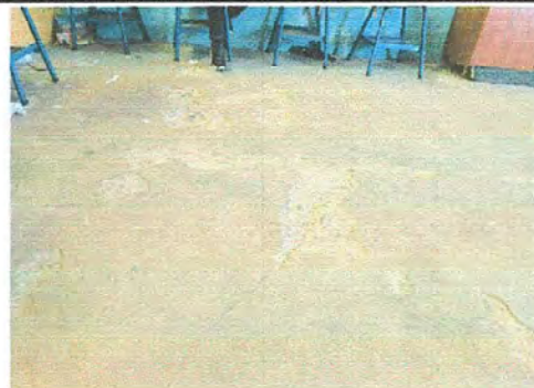
Foto 2: Módulo 1: Sustitución de piso de torta de concreto por piso de granito
