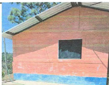
Foto 5: Módulo 4: Pintura en muros exteriores e interiores
