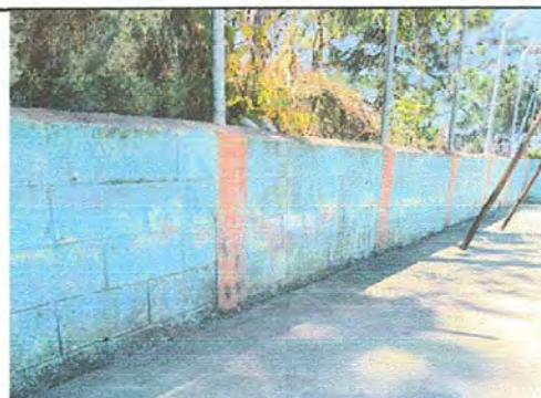
Foto 4: Muro perimetral: Pintura en muros exteriores e interiores
