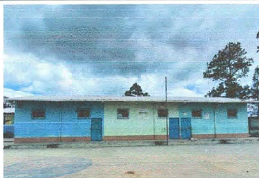
Foto 1: Módulo 1: Apertura y tallado de vano
