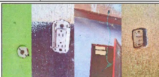
Foto 2: MODULO 1 Sustitución de focos ahorradores. Sustitución de plafoneras. Sustitución de interruptores simples. Sustitución de tomacorrientes. Sustitución de ductos eléctricos + accesorios. Sustitución de interruptores simples. Reparación de cableado eléctrico
