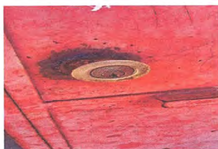
Foto 6: MODULO 1 Sustitución de chapas.
