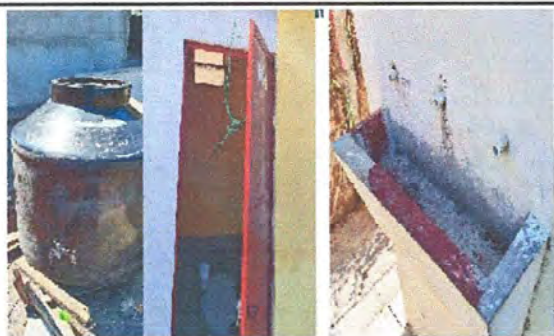
Foto 7: BAÑOS Sustrucción de accesorios inodoros, Sustrucción de depósito de agua 1000 lt, Sustrucción lavamanos.
