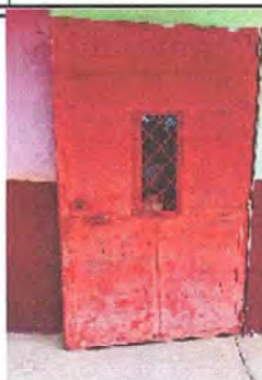
Foto 1: MODULO 1 Mantenimiento a estructuras de puertas
