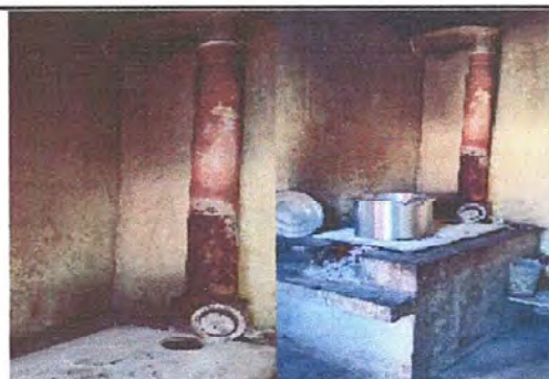
Foto 4: MODULO 1 Mantenimiento a estufa rural. Sustitución de chimenea de metal. Instalación de azulejo a estufa rural
