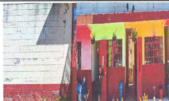
Foto 8: PINTURA GENERAL Pintura en muros interior y exterior
