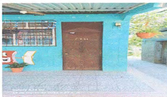
FOTO 4 Módulo 1. mantenimiento a estructura de puertas ( aplicación de pintura)
