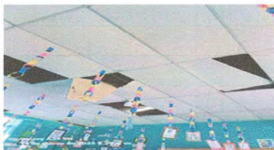
Foto 2. sustitución de cielo falso.
