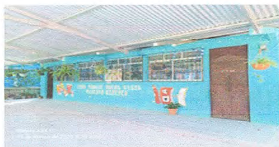
FOTO 3 Módulo 1: pintura de en muros interiores y exteriores.
