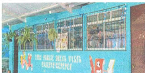
FOTO. 5 sustitución de ventanas de aluminio por PVC.
