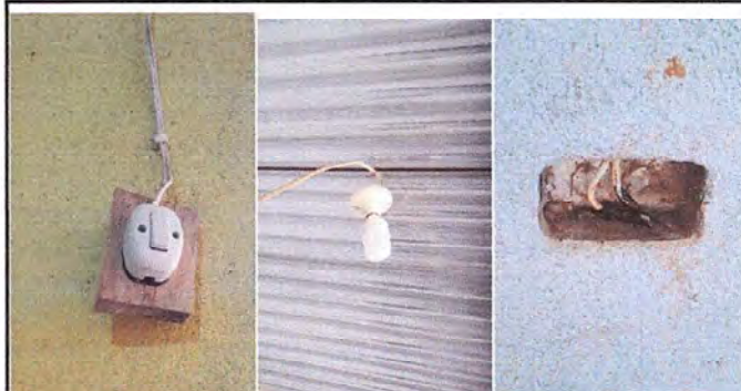
Foto 2: MODULO 1: Instalación de unidades luz (incluye interruptor, ducto y cable eléctrico)
