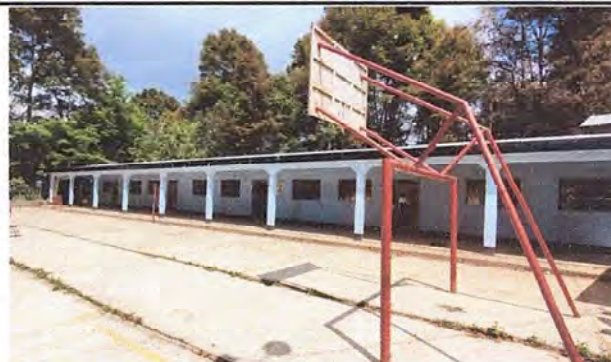
Foto 8: PINTURA GENERAL: Pintura en muros exteriores e interiores
