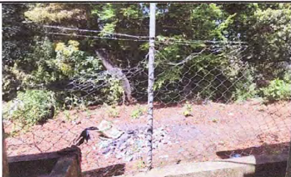
Foto 7: MURO PERIMETRALES: Reparación de tubo hg y malla galvanizada
