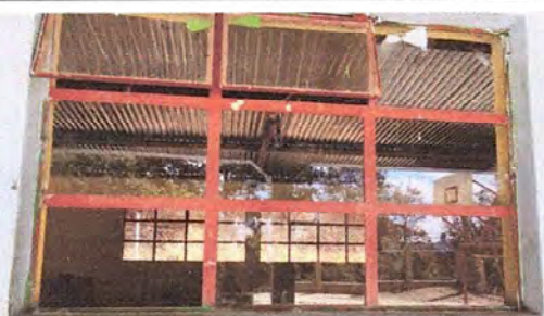
Foto 5: MODULO 1: Sustitución de vidrios
