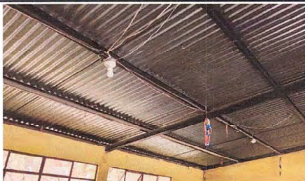
Foto 1: MODULO 1: Sustitución de lamparas tipo LED, Sustitución de ducto eléctrico + accesorios
