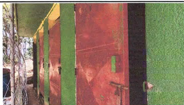
Foto 6: BAÑOS: Mantenimiento a estructura de puerta (lijado, cambio de tubo, cepillado, sujeciones, aplicación de pintura)
