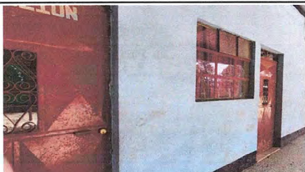
Foto 3: MODULO 1: Mantenimiento a estructura de puerta (lijado, cambio de tubo, cepillado, sujeciones, aplicación de pintura) y Sustitución de chapa a puertas
