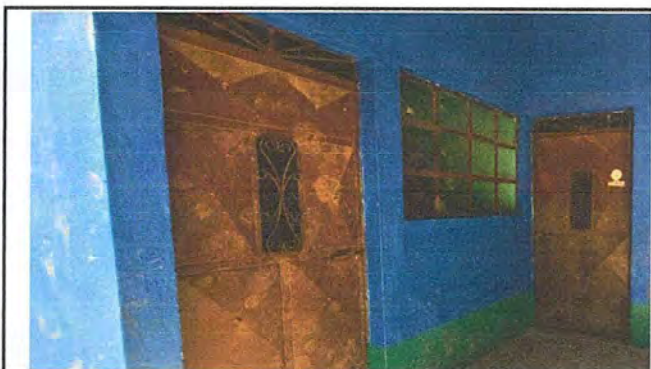
Foto 3: MODULO 1: Mantenimiento a estructura de puerta (lijado, cambio de tubo, cepillado, sujeciones, aplicación de pintura)
