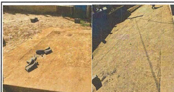
Foto 10: LOSA DE PATIO: Reparación de planchas de concreto de patio
