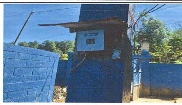
Foto 2: MODULO 1: Sustitución de tablero de flipones
