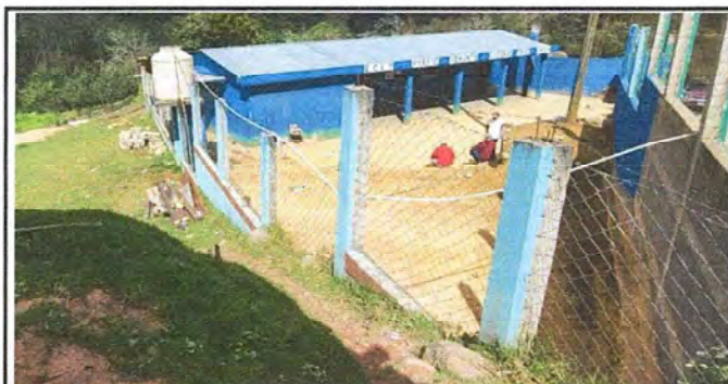
Foto 9: PINTURA GENERAL: Pintura en muros exteriores e interiores
