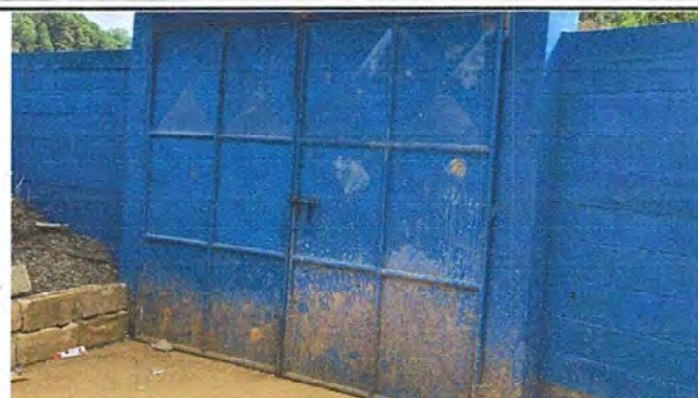
Foto 8: PUERTAS DE METAL: Mantenimiento a portones de metal y sustitución de chapa
