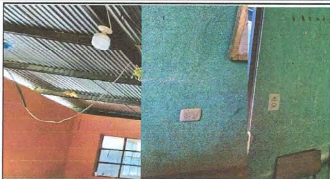
Foto 1: MODULO 1: Instalación de unidades luz (incluye interruptor, ducto y cable eléctrico)
