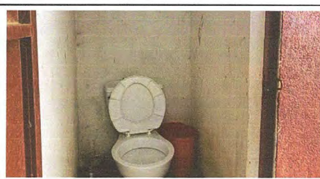
Foto 6: MODULO 1: Sustitución inodoro
