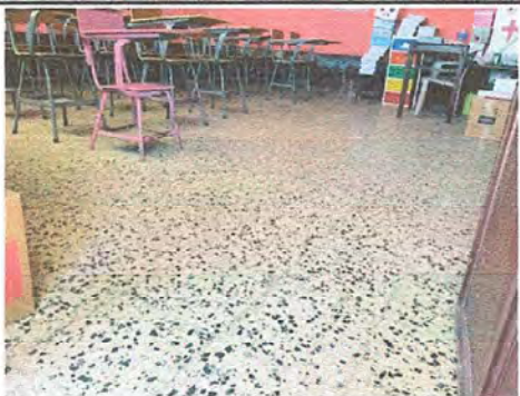
FOTO 1 Modulo 1: Sustrución de piso de granito por piso de porcelanato
