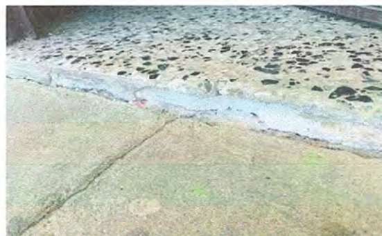
FOTO 2 Modulo 1: Sustrución de piso de granito por piso de porcelanato
