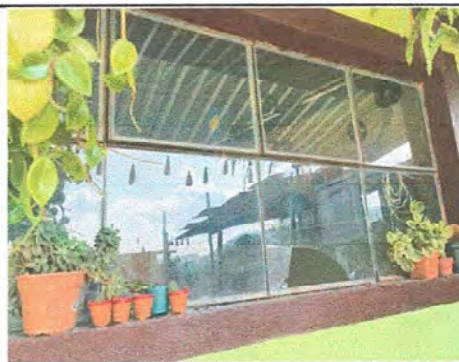
FOTO 4 Modulo 1: Suministro y fabricación e instalacion de 5 balcones de hierro de ventana
