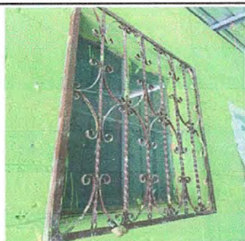
FOTO 5 Modulo 1: Sustrución de balcón de metal
