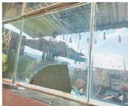
FOTO 3 Modulo 1: Sustrución de estructura de metal de ventana por ventana PVC
