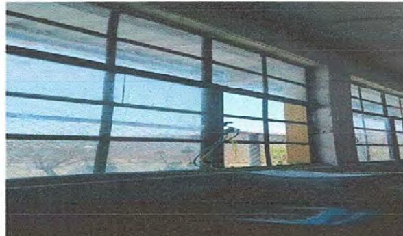
FOTO 4: MÓDULO 2: SUSTITUCIÓN DE VENTANAS DE METAL POR PVC MÁS VIDRIO
