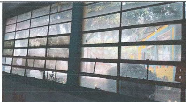
FOTO 1: MÓDULO 1: SUSTITUCIÓN DE VENTANAS DE METAL POR PVC MÁS VIDRIO
