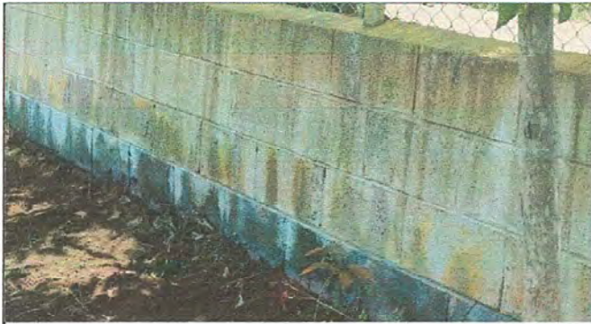
FOTO 7: MURO PERIMETRAL: PINTURA EN MUROS EXTERIORES E INTERIORES
