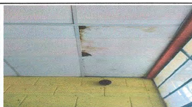
FOTO 6: MÓDULO 2: SUSTITUCIÓN DE CIELO FALSO
