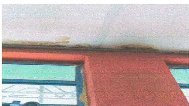
FOTO 3: MÓDULO 1: SUSTITUCIÓN DE CIELO FALSO
