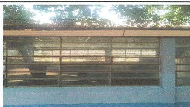
FOTO 2: MÓDULO 1: SUMINISTRO E INSTALACIÓN DE BALCONES DE METAL EN VENTANA
