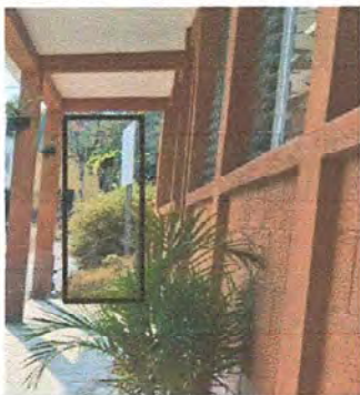
Foto 1 - Módulo 1: suministro e instalación de puerta de metal en módulo
