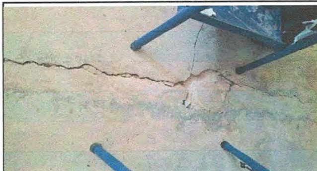
Foto 4 - Módulo 1: sustitución de piso de torta de concreto por piso cerámico.
