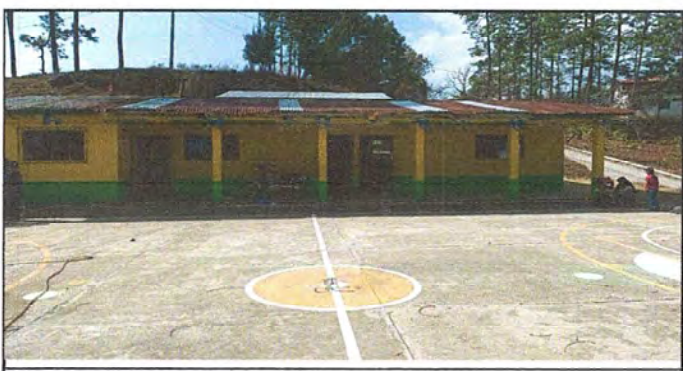
Foto 11 modulo 1: pintura en muro exterior e interior
