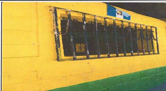
Foto 8 Modulo 1: Sustrucción de balcones de metal
