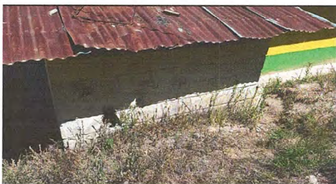
Foto 9 Modulo 1: Suministro de canal pvc
