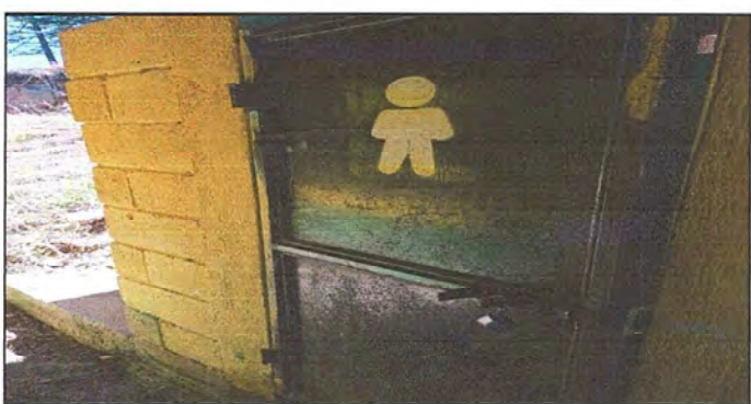
Foto 6 Modulo 1: Sustitución de puertas para baños
