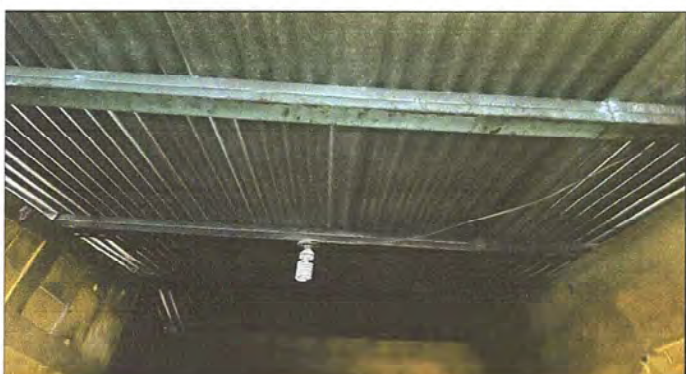
Foto 3 Modulo 1: Mantenimiento de estructura de soporte
