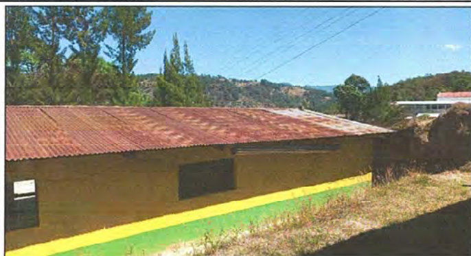
Foto 1 Modulo 1: Sustitución de lámina de metal por lámina troquelada aluzinc 26,
