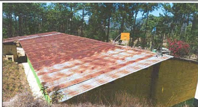
Foto 2 Modulo 1: Sustitución de capote de lámina para lámina troquelada
