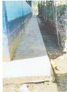
Módulo 1. Foto 4: Sustitución de piso de concreto corredor
