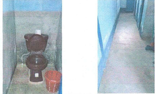
Módulo 1. Foto 2: Sustitución de piso de granito
