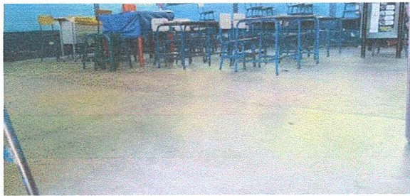
Módulo 1. Foto 1: Sustitución de piso de granito
