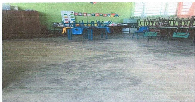
Foto 3: Modulo 1: sustitucion de piso de cemento liquido por piso ceramico antideslizante.
