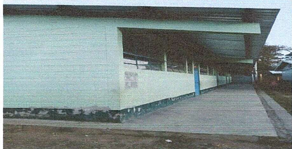
Foto 1: Modulo 1: sustitucion de piso de cemento liquido por piso ceramico antideslizante.
