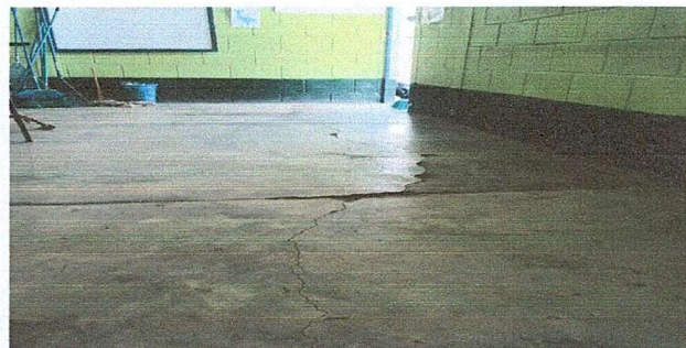
Foto 2: Modulo 1: sustitucion de piso de cemento liquido por piso ceramico antideslizante.
