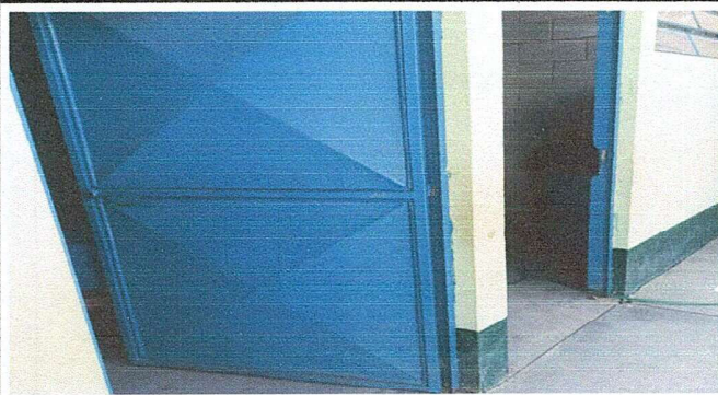
Foto 4: Modulo 1: mantenimiento a estructura de puerta (lijado cambio de tubo cepillado sugesion y aplicacion de pintura)
