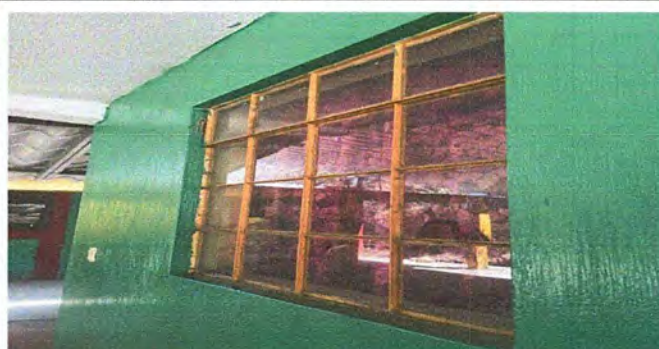
Foto 2 Módulo 1: Sustitución de ventanas de metal por ventanas de PVC con vidrios
