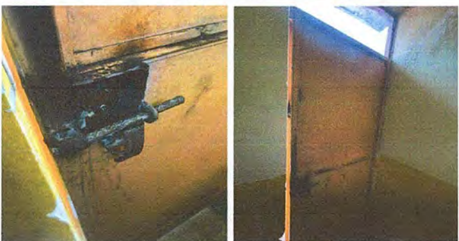
Foto 3 Módulo 1: Sustitución de chapas
