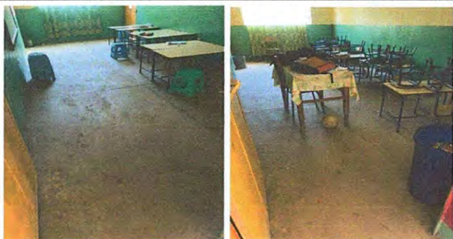
Foto 1 Módulo 1: Sustitución de piso de torta de concreto por piso cerámico
