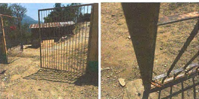
Foto 5 Módulo 1: Mantenimiento de estructura de puerta (lijado, cambio de tubo, cepillado, sujeciones, aplicación de pintura)
