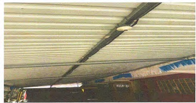
Foto 4 Módulo 1: Instalación de unidades luz (incluye interruptor, ducto y cable eléctrico)
