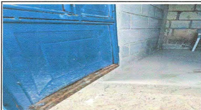
Foto 7. Módulo 4. Sustitución de puertas de metal en servicios sanitarios.
