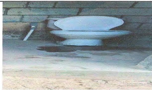
Foto 8. Módulo 4: Sustitucion de inodoro
