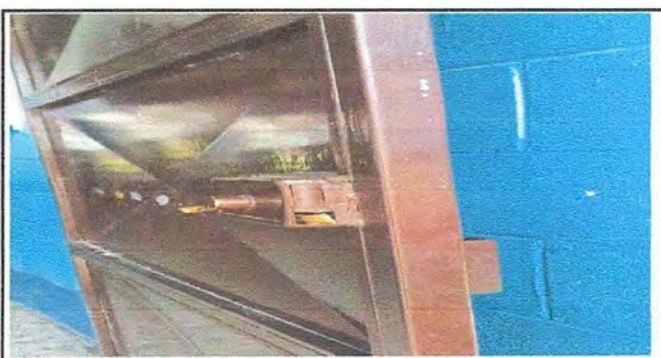
Foto 11: Módulo 4. Sustitución de chapa.
