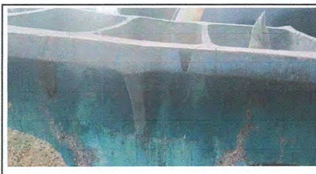
Foto 12: Módulo 4. Sustitución de pila de cemento por pila de plastico de dos lavaderos
