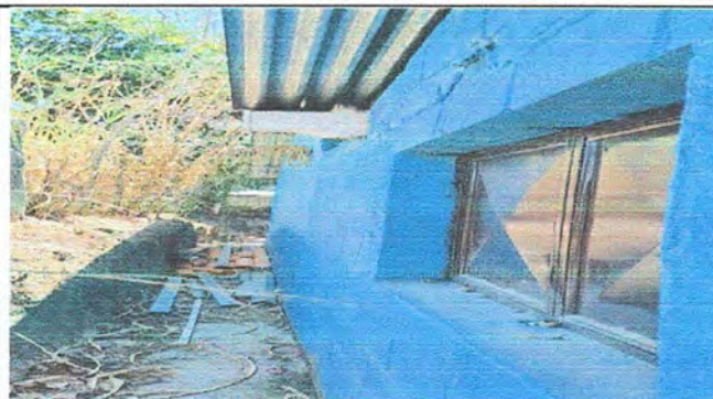
Foto 2. Módulo 1: Sustrucción de canal de pvc.
