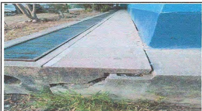
Foto 9: Módulo 4. Reparación de banquetas de concreto.
