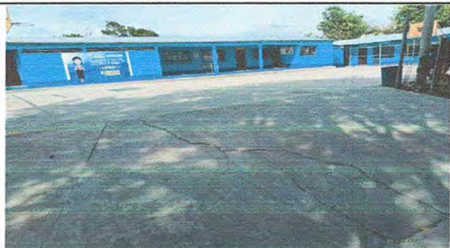
Foto 13. Muro Perimetral. Sustitución de torta de concreto por adoquines
