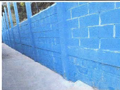
Foto 12: Módulo 4: Repello de muro de contención (Muro perimetral)
