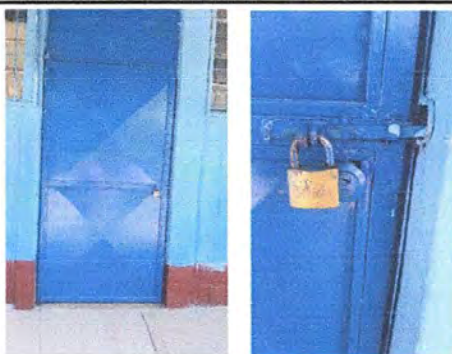
Foto 3: Modulo 2: Sustitución de chapa
