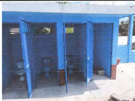
Foto 10: Módulo 3: Sustitución de torta de concreto por piso de cerámico antideslizante
