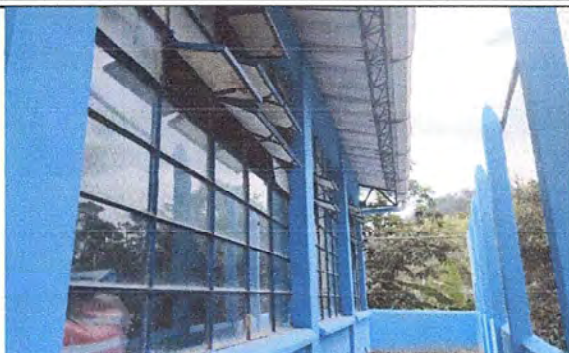
Foto 1: Modulo 1: Suministro e instalación de balcon de hierro en ventana
