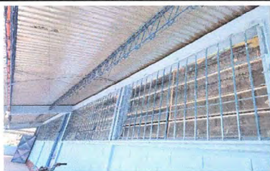
Foto 5: Modulo 2: Sustitución de ventana de metal PVC Más vidrio
