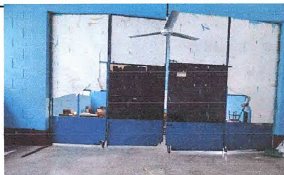
Foto 4: Modulo 2: Mantenimiento a muro divisorio (3 mts de alto x 5 mts de ancho)
