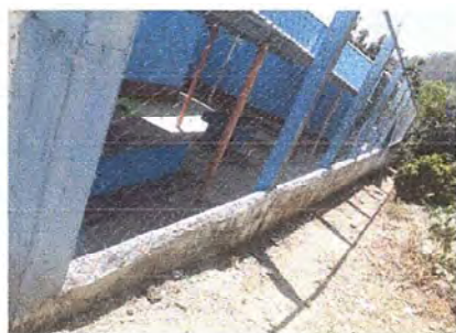
Foto 11: Modulo 4: Pintura en muros exteriores e interiores
