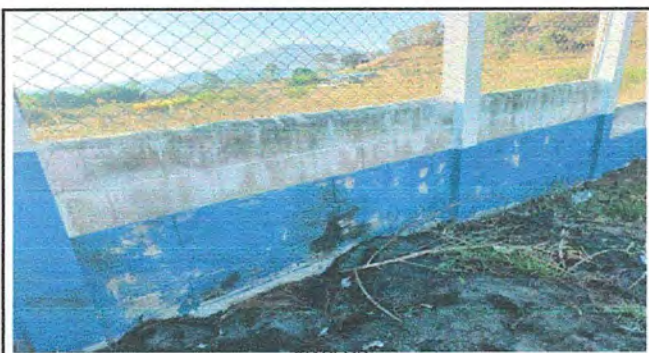
Foto 5: Modulo 3 La pintura de toda la circulación se encuentra dañada.
